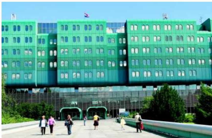
Slika 3.1 Izgled Kliničke bolnice Zagreb izvana
