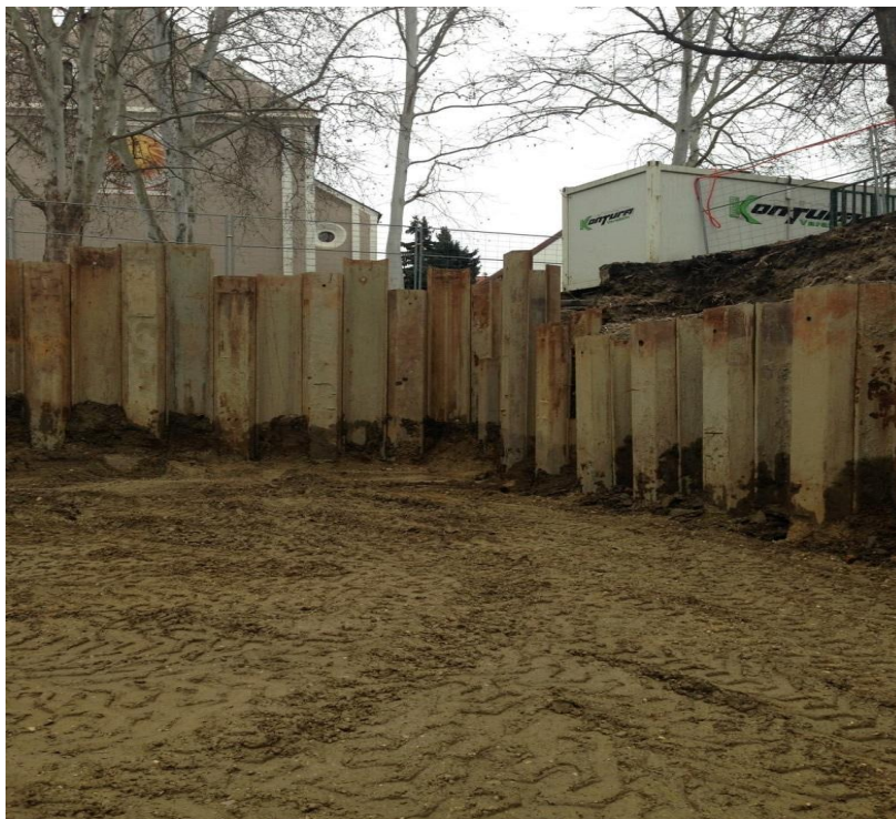
Slika 23. Građevinska jama nakon uređenih drenova
