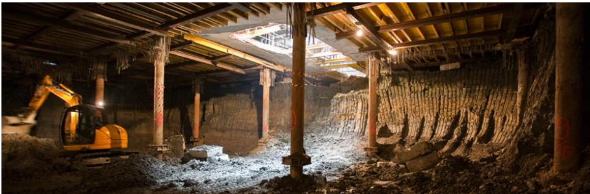
Slika 4. Iskop rova metodom „TOP DOWN“
