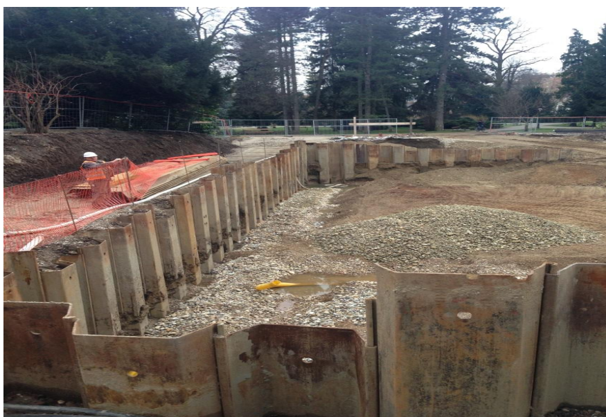
Slika 23 b)Zatrpavanje građevinske jame batudom
