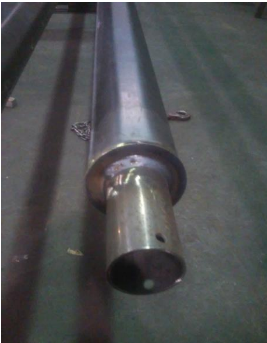
Slika 5.15. Ugradnja i zavarivanje cijevi umetka
