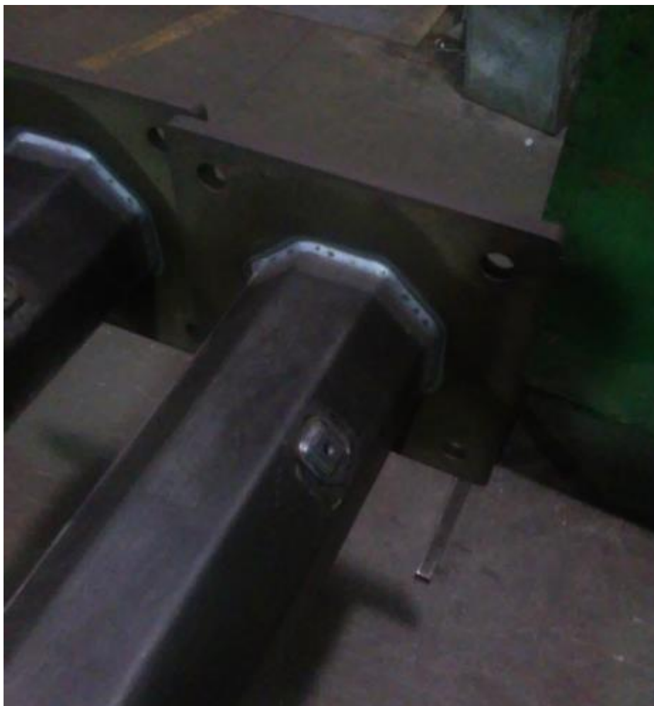
Slika 5.14. Ugradnja i zavarivanje temeljne ploče
