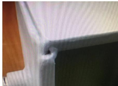
*Slika 4.4 Nepretaljeni završetak zavara, potencijalno mjesto nakupljanja nečistoće, hrđanja*
