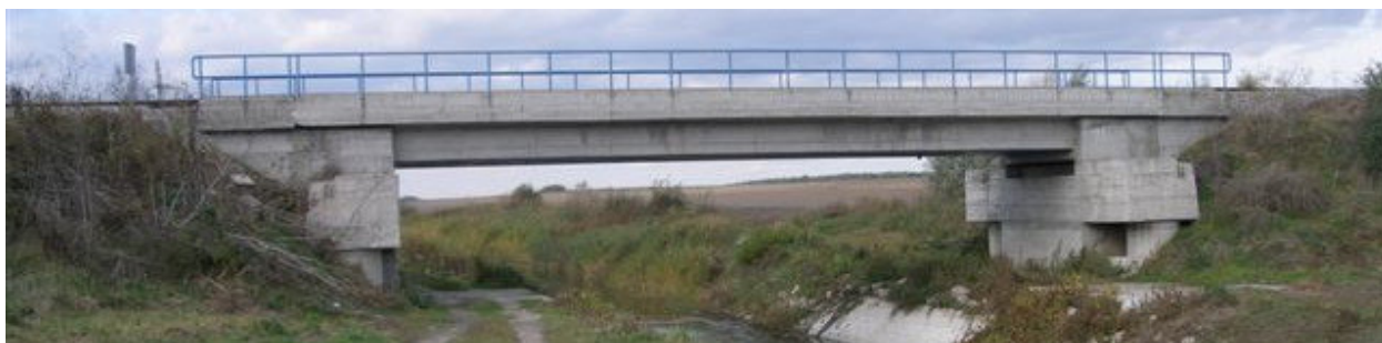
Slika 1.1-2 Armirano-betonski most Vuka (izvor: arhiva ŽPD d.d.)
