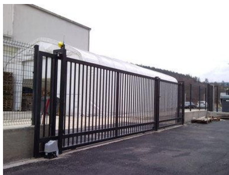
Slika 2.3. Klizna dvorišna vrata s vodilicom [3]
