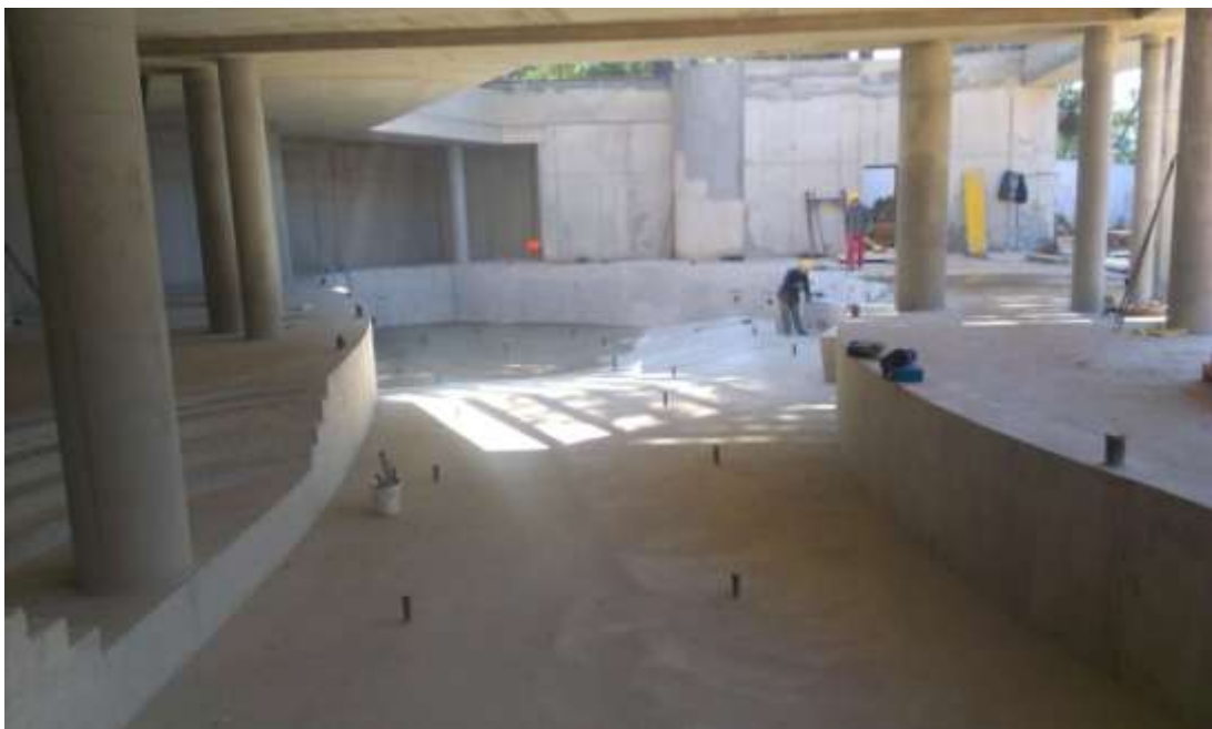
slika 6.2.1.: unutarnji bazen hotela Bellavue pripremljen za izolacijske radove
