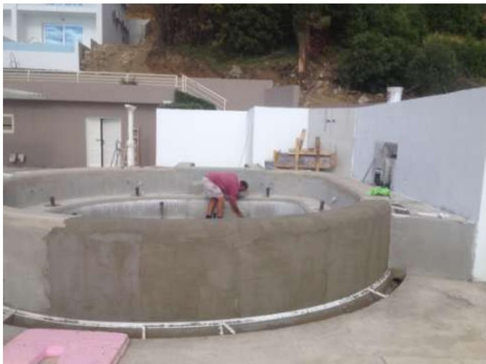
*slika 6.2.4.: Postavljanje hidroizolacije na vanjskom bazenu hotela Nimfe*
