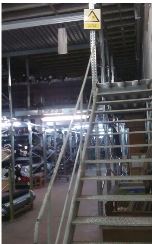
Slika 18. Stube za pristup podestu
