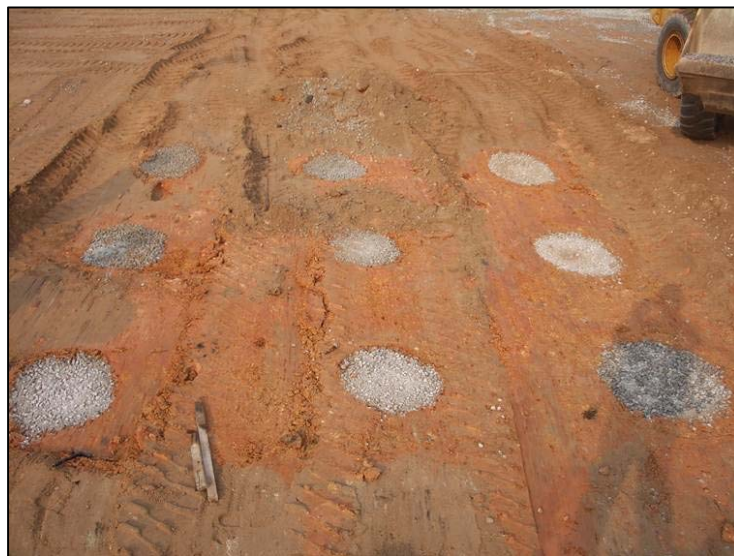
Slika 2.2. Izgled šljunčanih pilota u kvadratnom rasporedu.
