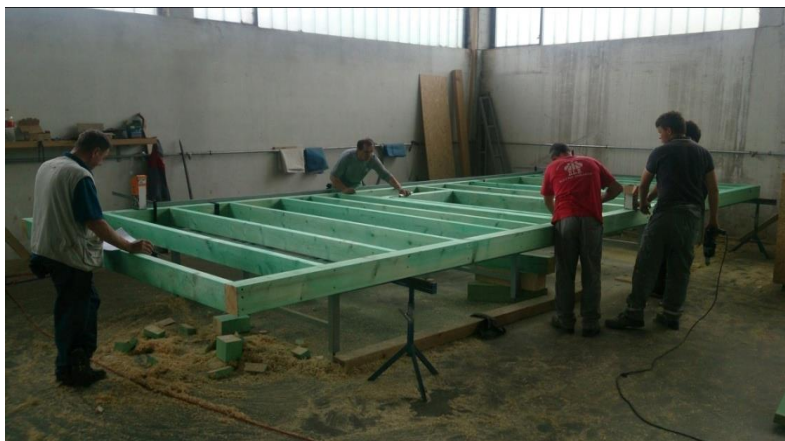
Slika 9. Sklapanje zida
