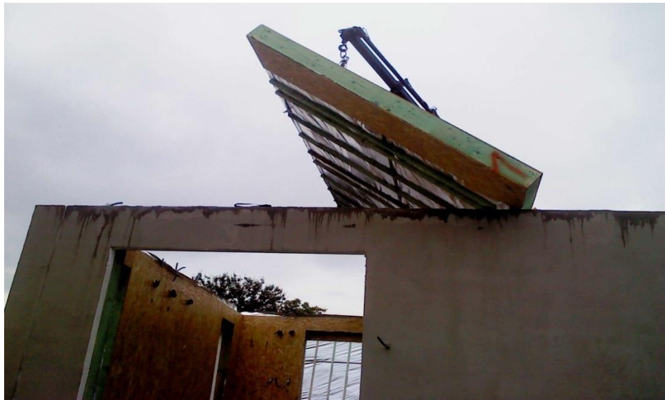
Slika 39. Montaža pomoću dizalice
