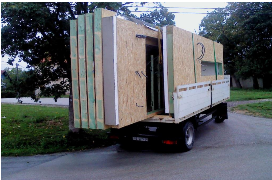
Slika 38. Dovoz gotovih zidova na gradilište
