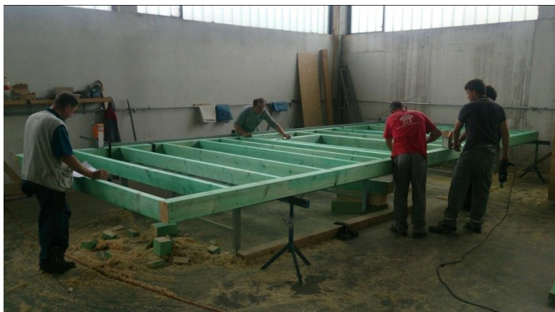
Slika 9. Sklapanje zida
