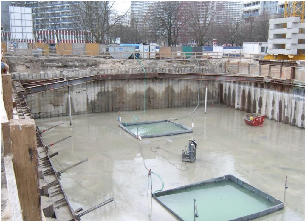
Slika 13. Voda u građevinskoj jami
