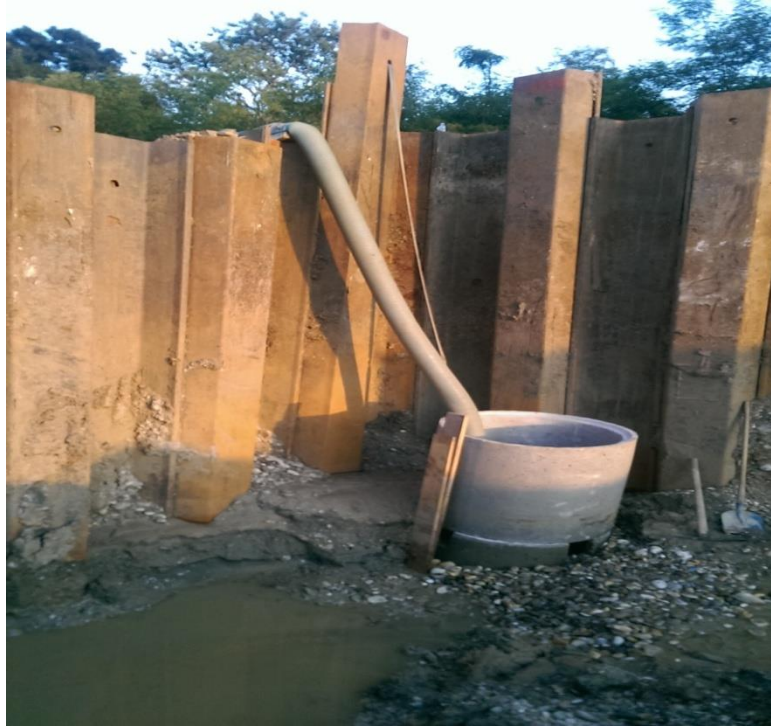
Slika 50. Crpljenje vode crpkama
