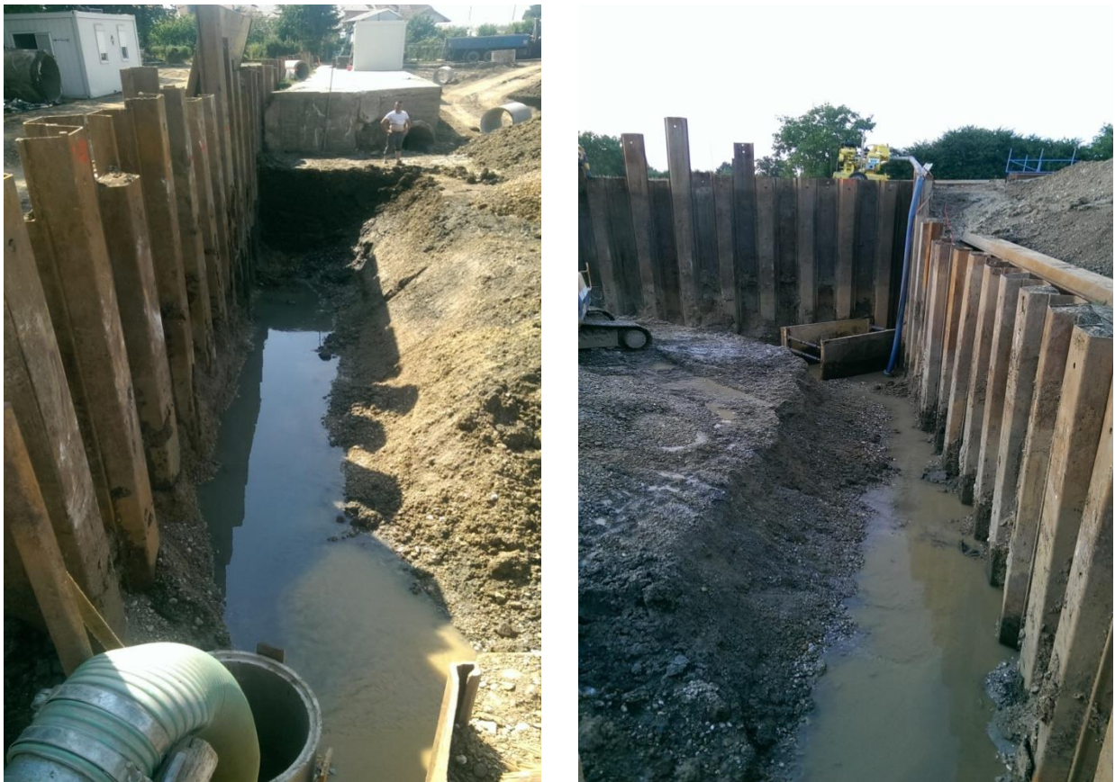
Slika 49. Voda u građevinskoj jami KP-II
