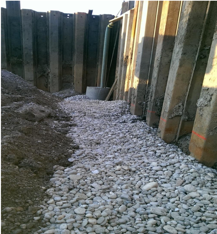
Slika 52. Zatvaranje rova batudom
