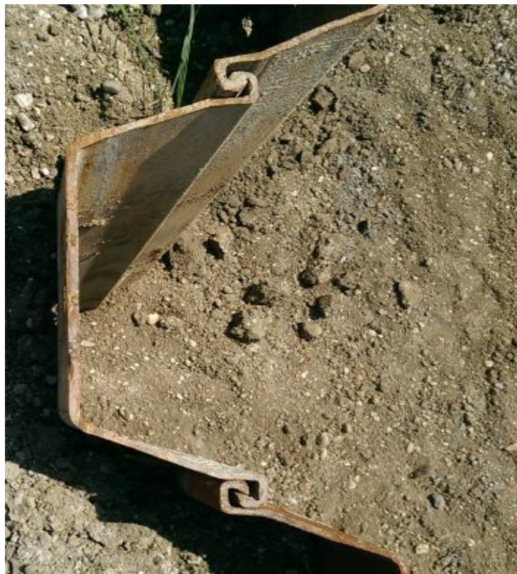
Slika 44. Način spajanja žmurja
