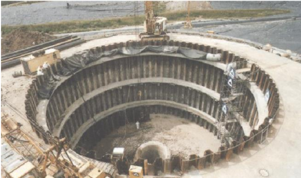
Slika 7. Zagatna stijena od čeličnog žmurja
