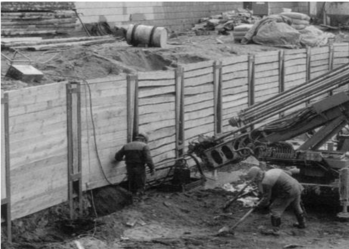
Slika 3. Berlinski zid od drvenih platice
