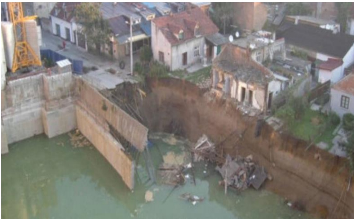
Slika 15. Posljedice hidrauličkog sloma tla u Kupskoj ulici
