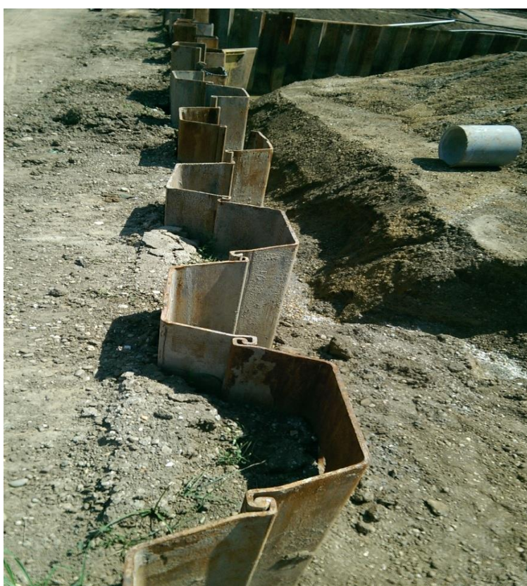
Slika 45. Postavljanje žmurja kontinuirano, jedan panel do drugog
