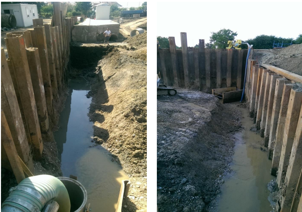
Slika 49. Voda u građevinskoj jami KP-II
