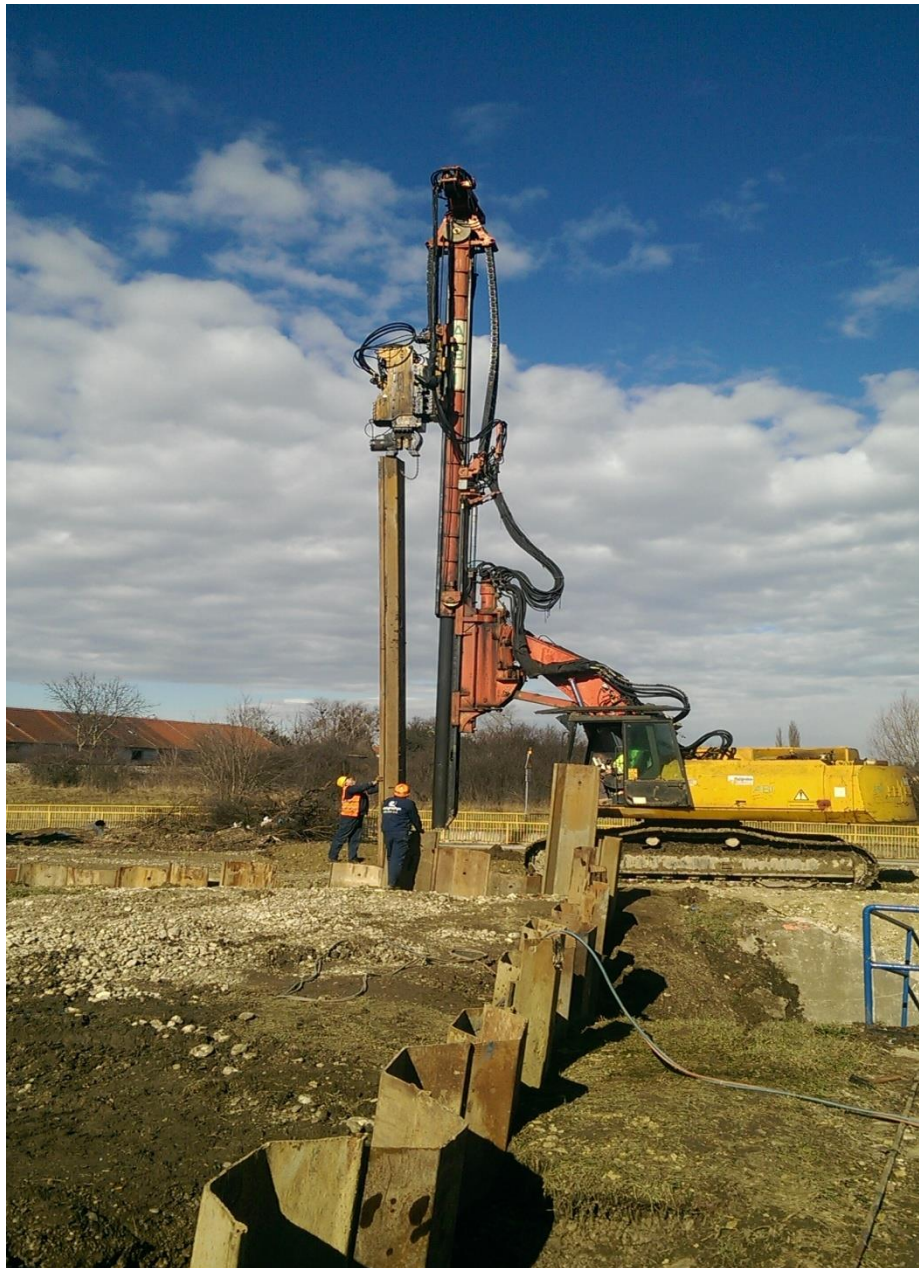
Slika 46. Ugradnja žmurja vibronabijačem
