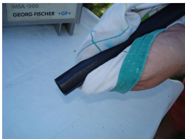
Slika 3.8. Priprema cijevi a) odmašćivanje cijevi krpom b) medicinski alkohol [13]
