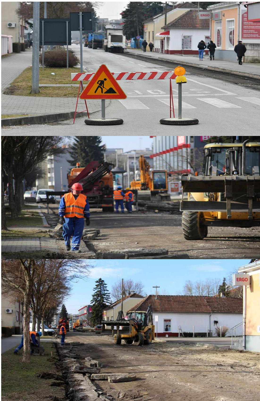
Slika br.10 : Radovi u tijeku (vlastiti izvor)
