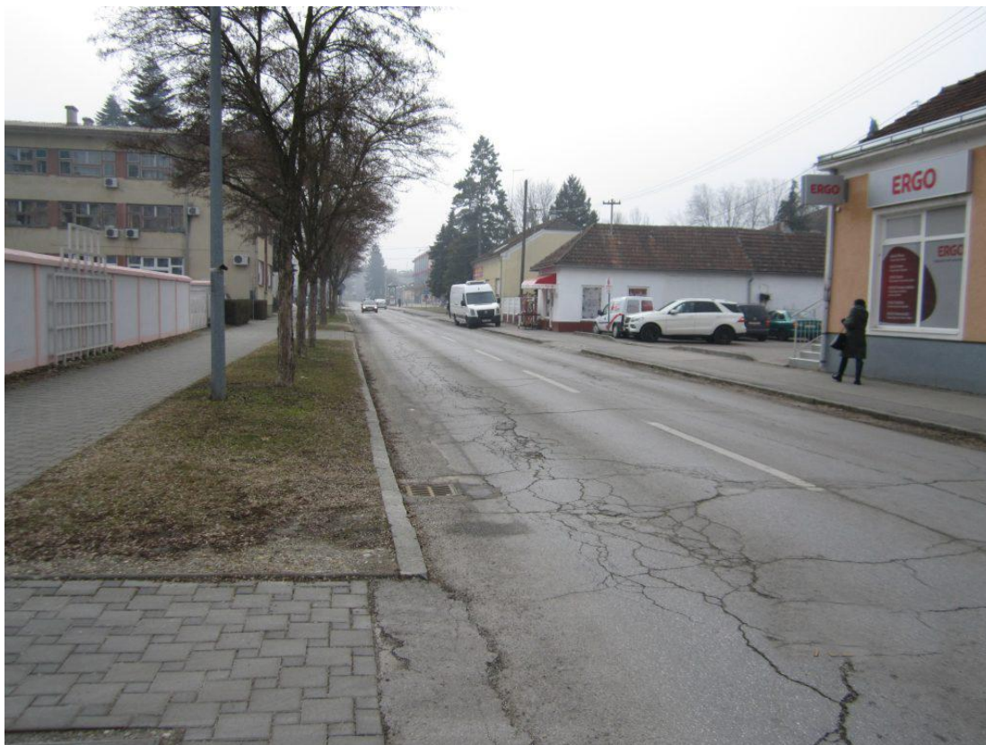
Slika br.9: Stanje prometnice prije rekonstrukcije (vlastiti izvor)
