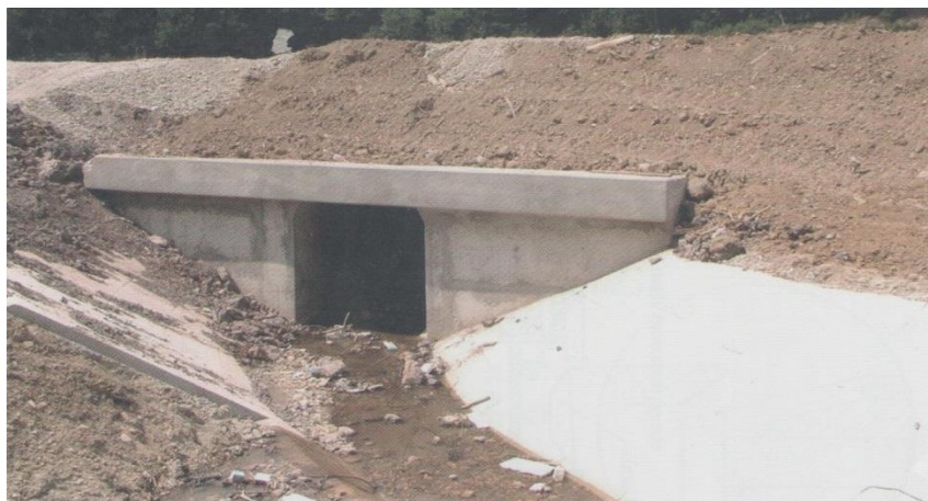
Slika 14. Pločasti propusti
