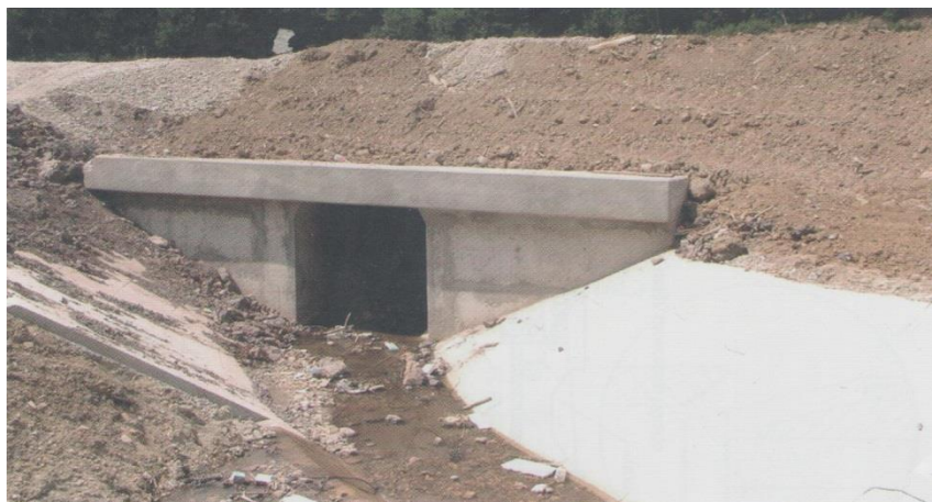
Slika 14. Pločasti propusti
