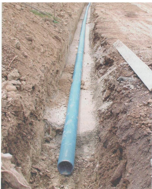
Slika 11. Plastična drenažna cijev na podlozi od betona
