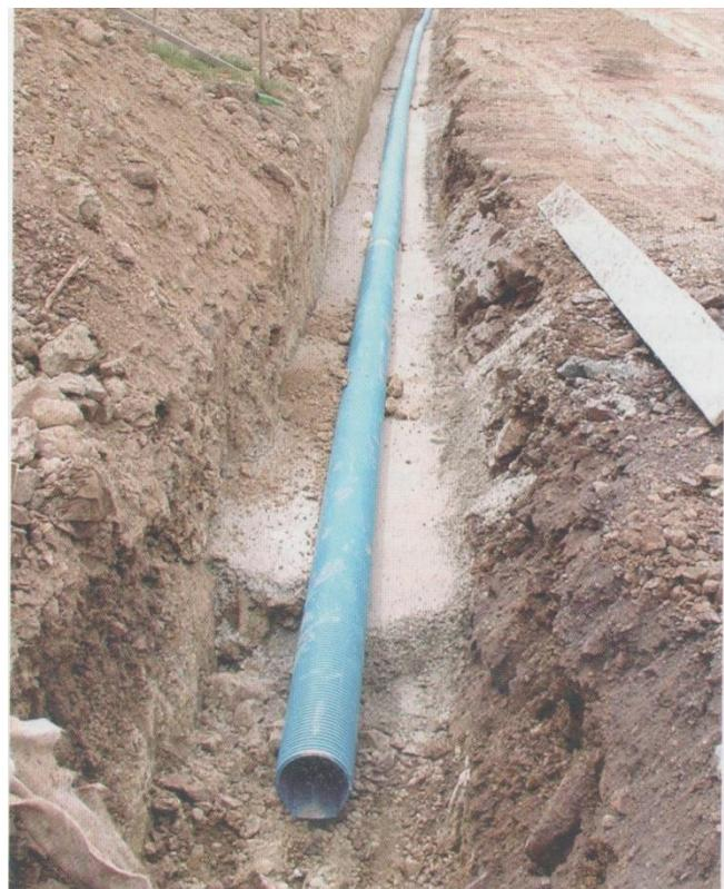
*Slika 11. Plastična drenažna cijev na podlozi od betona*
