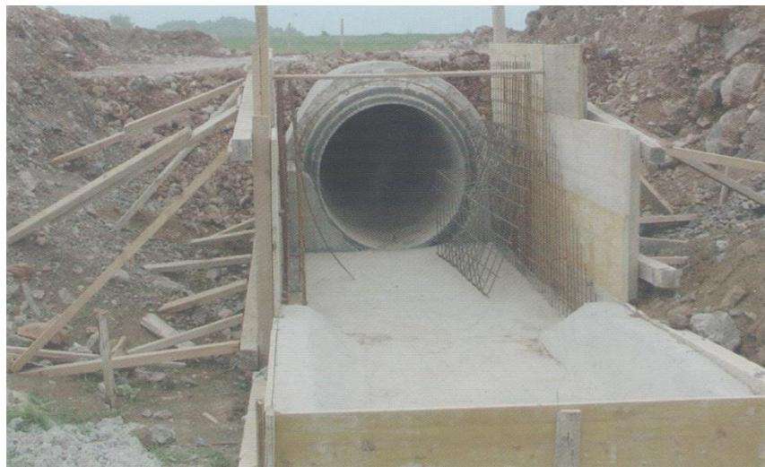
*Slika 13. Cijevni propusti*
