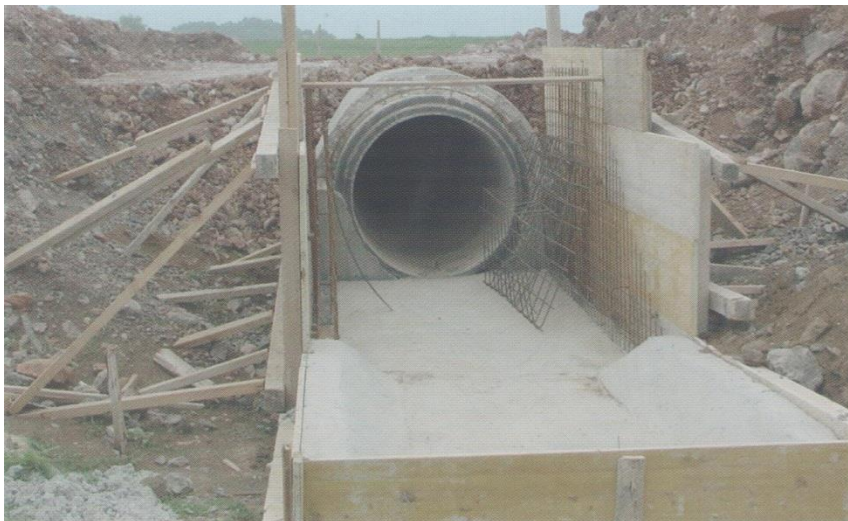
Slika 13. Cijevni propusti
