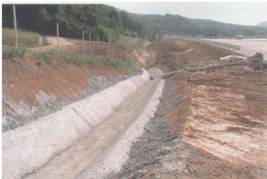
*Slika 2. Trapezni odvodni jarak*
