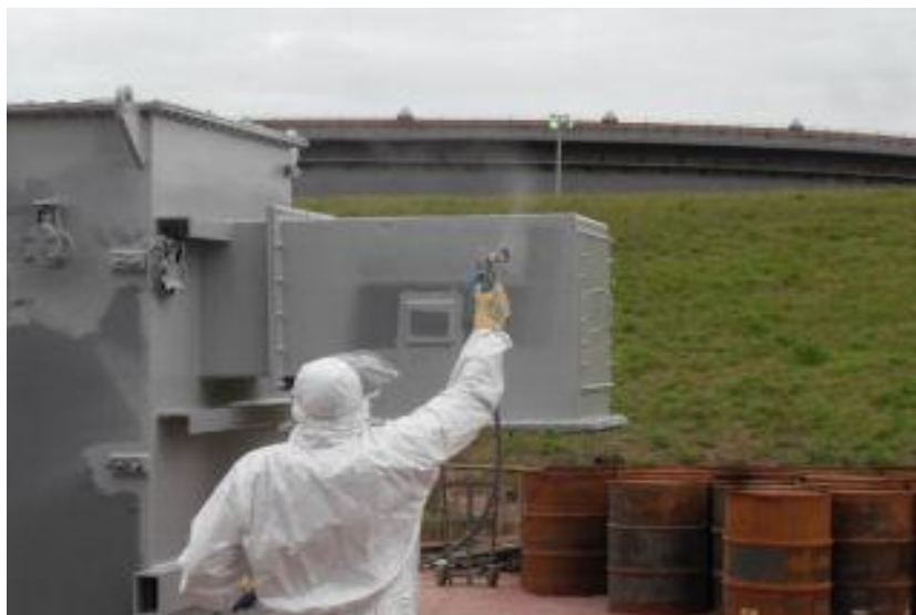
Slika 7. Nanošenje premaza bezračnim štrcanjem [6]
