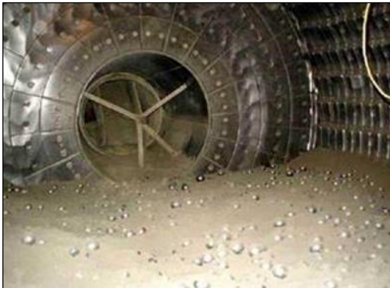
Slika 2.2. Unutrašnjost mlina s kuglama za mljevenje klinkera (Ćurković 2015.)
