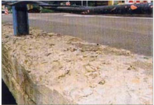
Slika 3.3. Primjeri oštećenja prilikom smrzavanja i odmrzavanja
