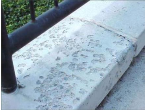
Slika 3.3. Primjeri oštećenja prilikom smrzavanja i odmrzavanja
