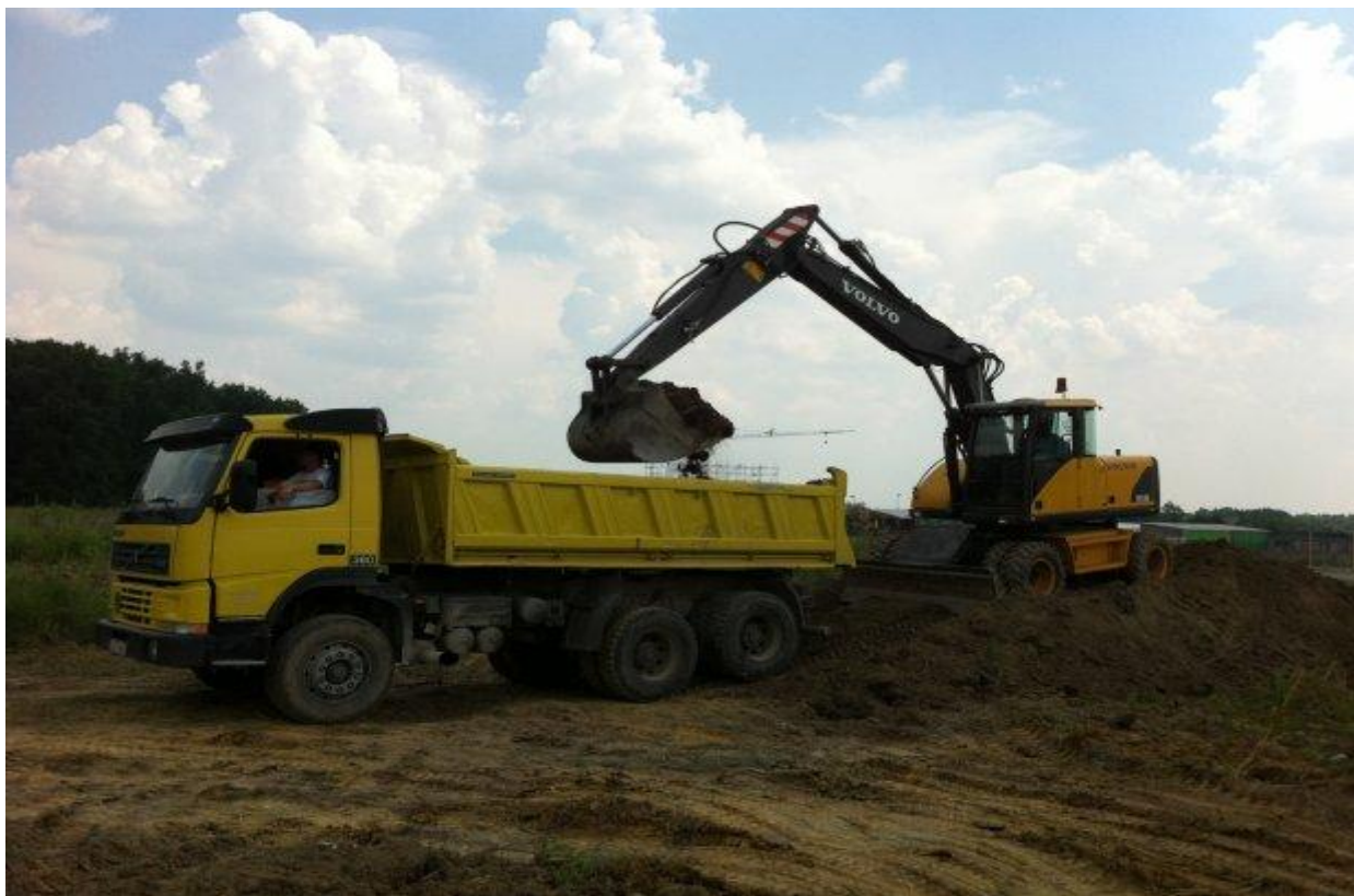
Slika 7. Utovar zemlje bagerom u kamion kiper
