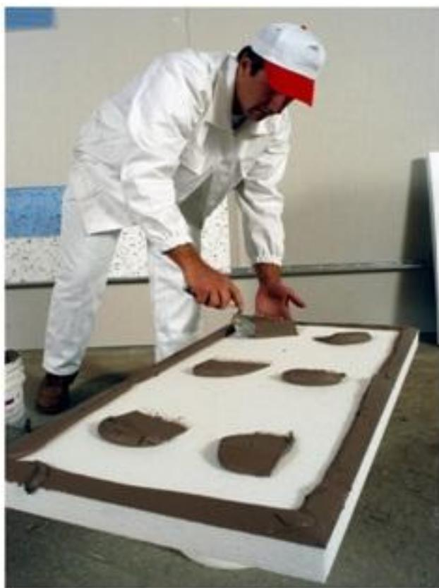
Slika 7. Nanošenje ljepila na stiropor ploču
