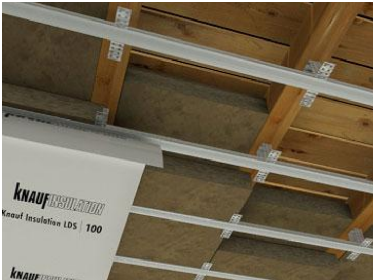
Slika 11. Izvedba kosog krova sa mineralnom vunom
