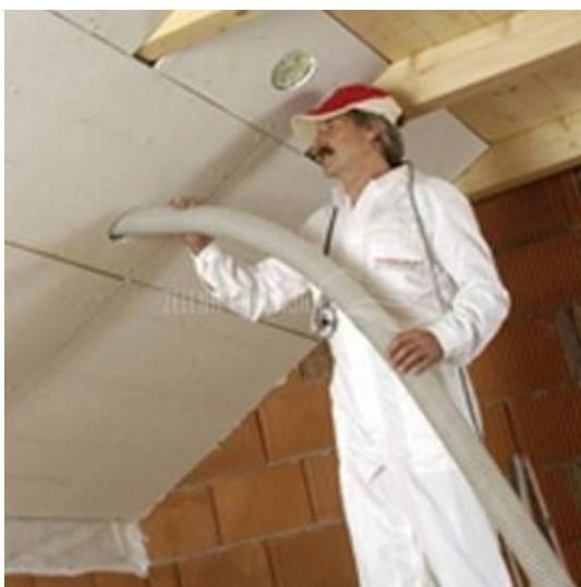
Slika 20. Ugradnja papira u konstrukciju (upuhivanje)
