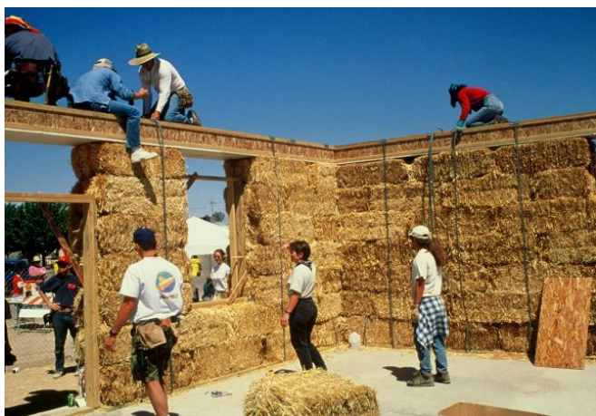
Slika 18. Izrada kuće od slame
