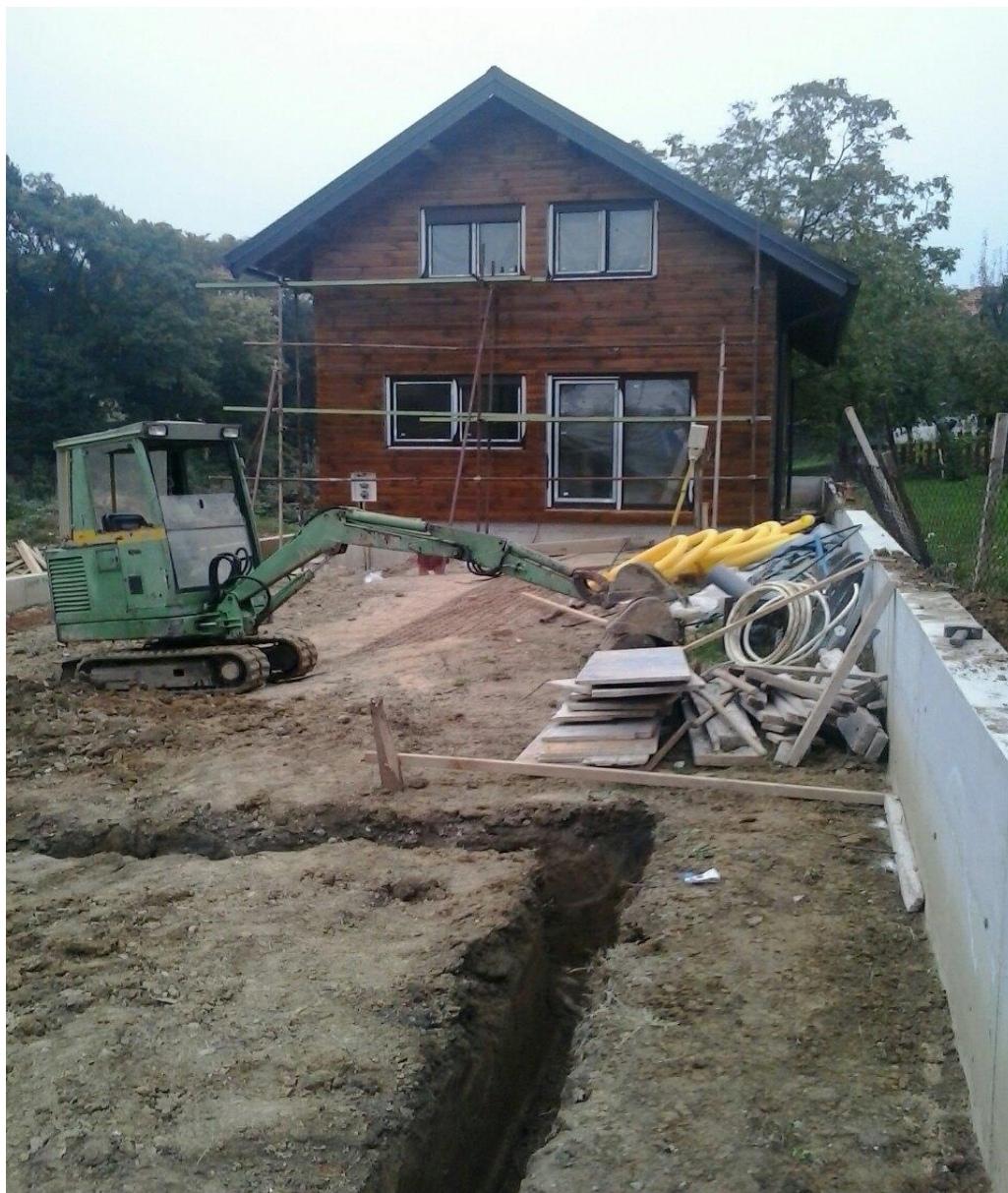
Slika 6.5 Zemljani radovi za elektroinstalacije
