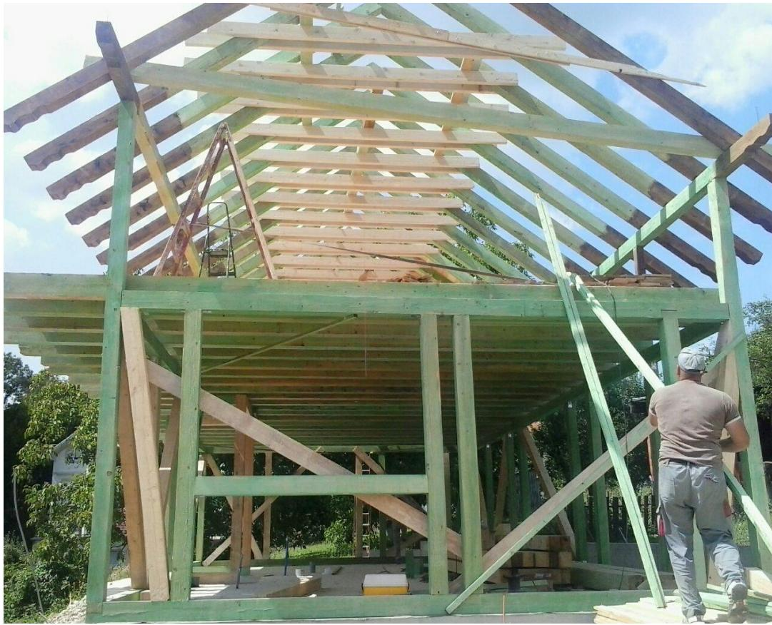
Slika 6.7 Izrada nosivih i unutrašnjih zidova od drvenih stupova i greda, te izrada kompletног drvenog krovišta
