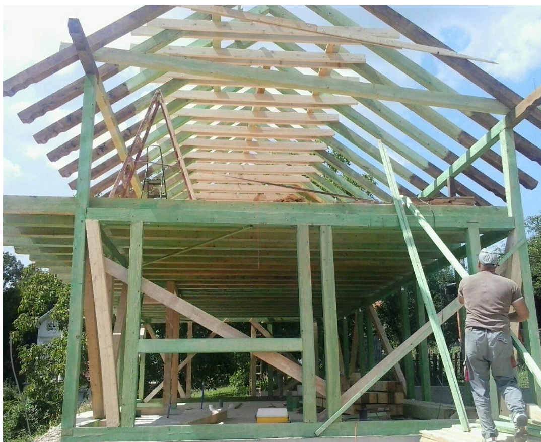
Slika 6.7 Izrada nosivih i unutrašnjih zidova od drvenih stupova i greda, te izrada kompletnog drvenog krovišta
