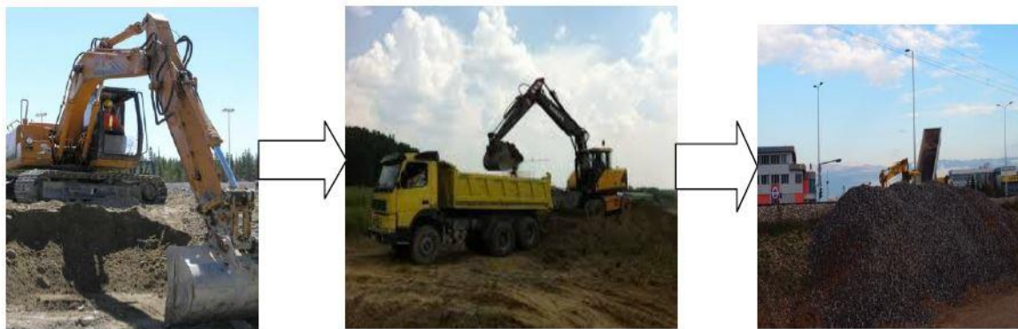
Široki iskop materijala
