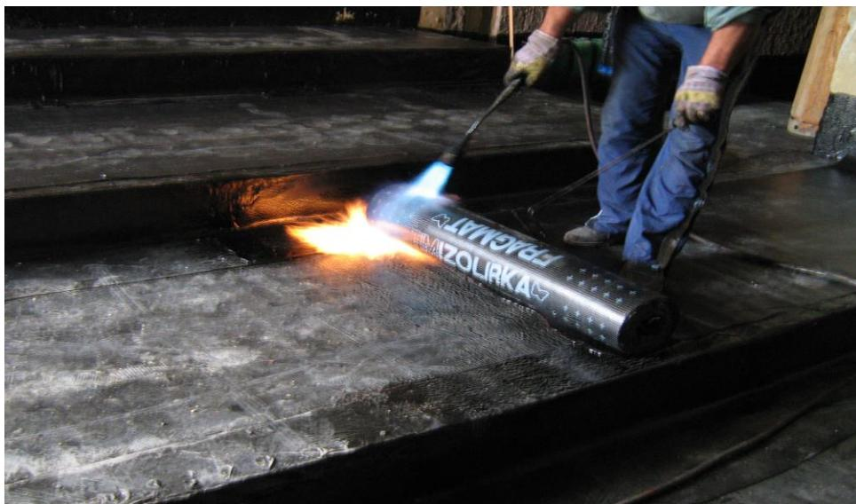
Slika 3.5. Prikaz postave horizontalne hidroizolacije, varenje ljepenke V3
