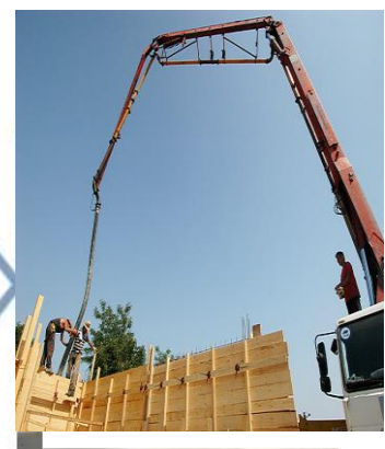
Ugradnja betona
