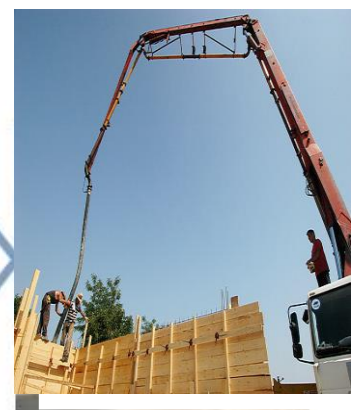
Ugradnja betona
