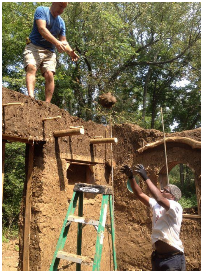
Slika 10 Gradnja kuće cobom
