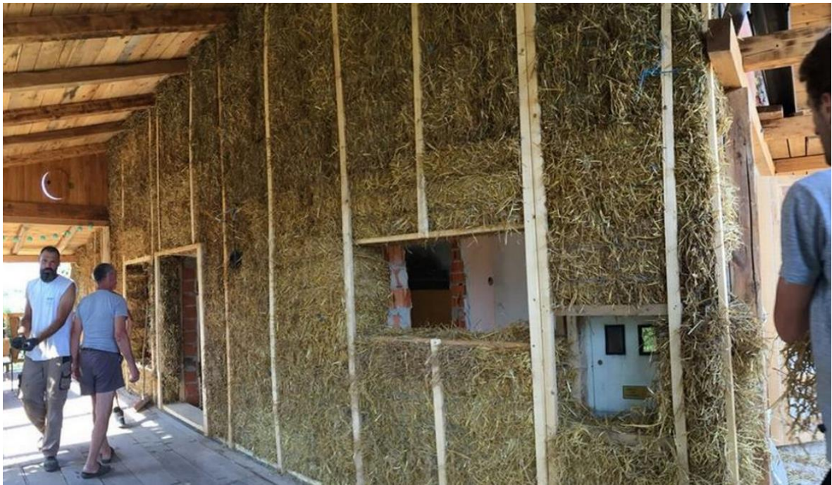
Slika 25 Na dijelu gdje je otvor vidi se debljina zida
