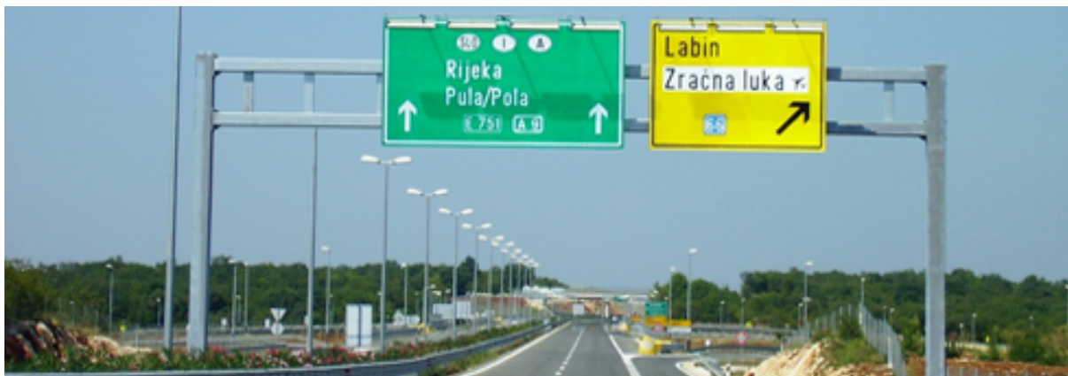
Slika 8.2 Portal na autocesti
