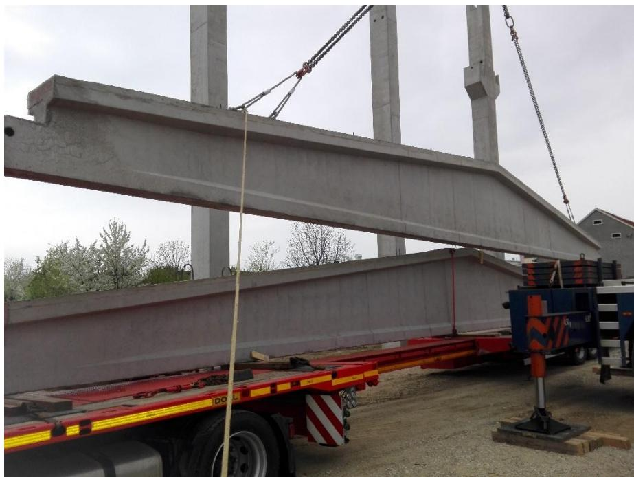
*Slika 4.10. Doprema glavnog krovnog nosača te montiranje istog*
