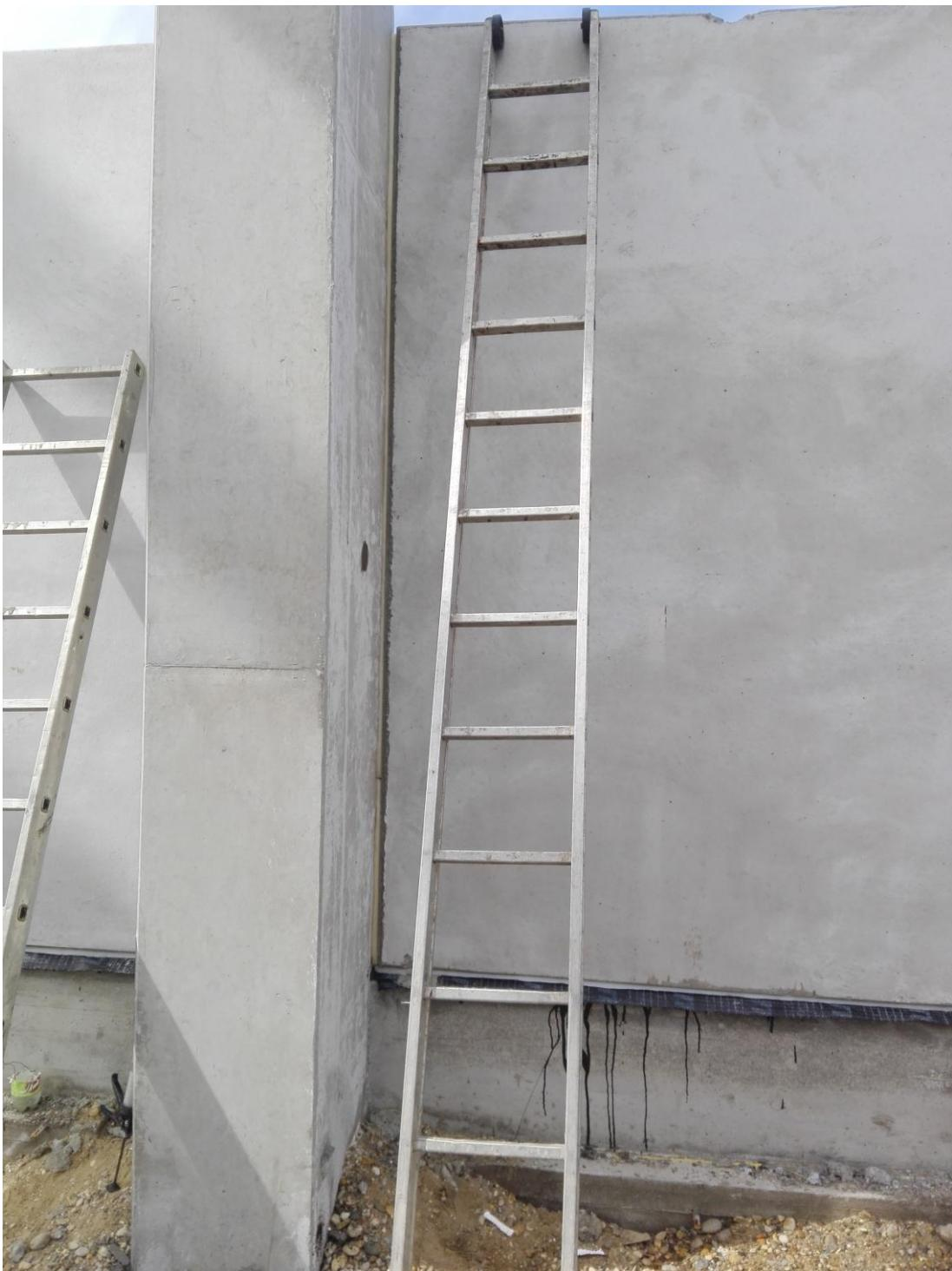
*Slika 4.19. Prikaz vertikalnih i horizontalnih spojeva sa AB troslojnom fasadom*
