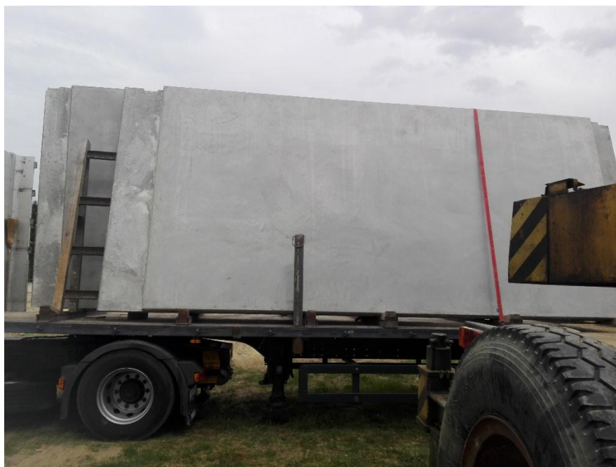
Slika 4.16. AB troslojni fasadni paneli na kamionu
