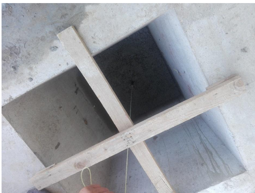
Slika 4.4. Prikaz načina centriranja čašice pomoću takozvanog križa i viska
