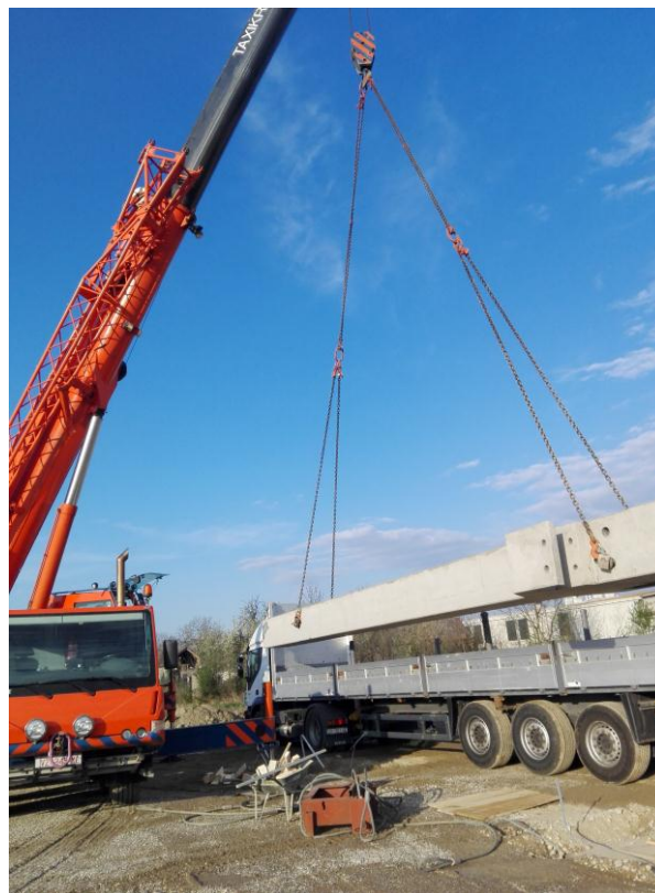
Slika 4.7. Istovar AB stupa sa kamiona pomoću auto dizalice
