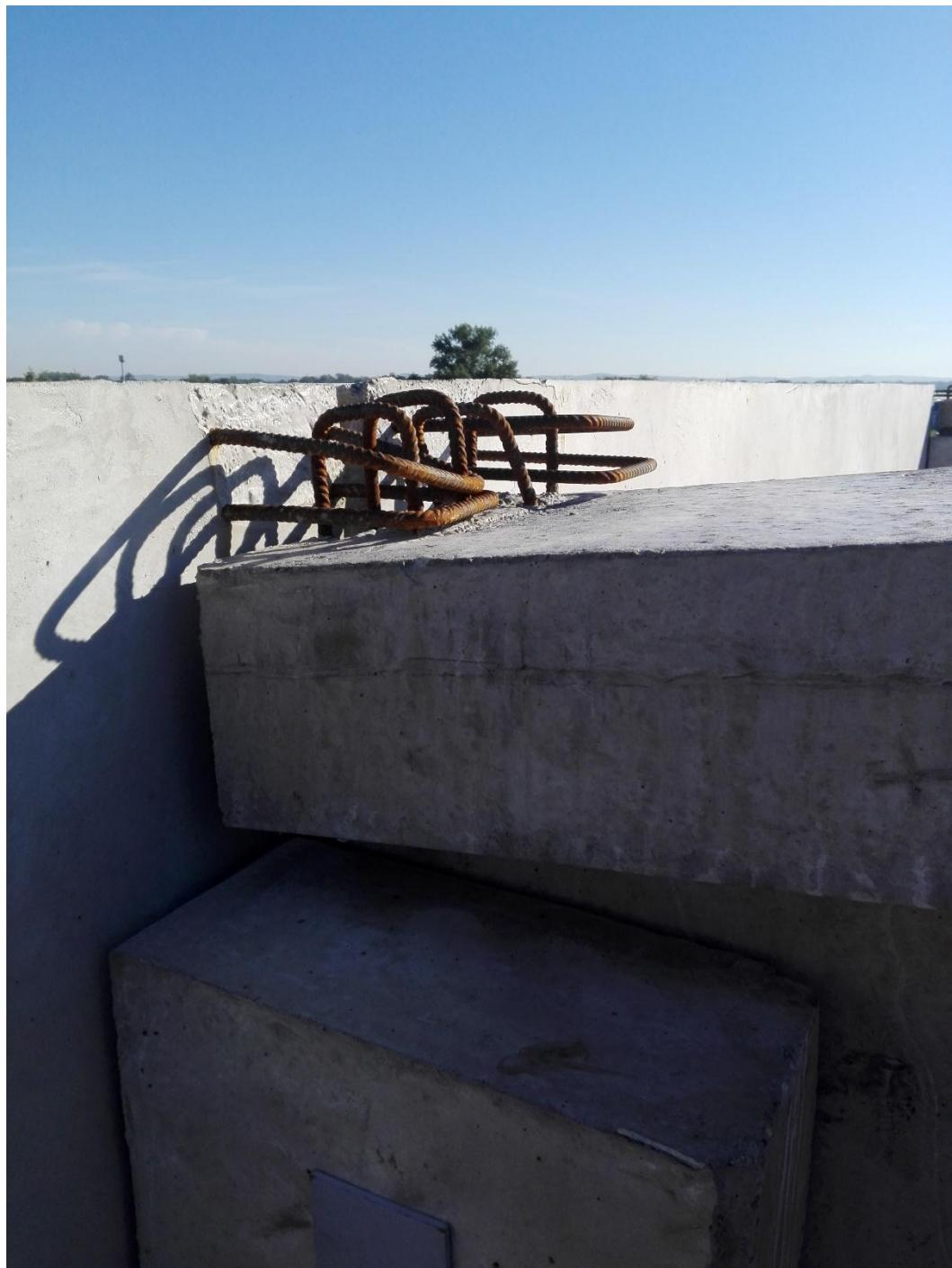
Slika 4.20. Spoj prednapetog AB krovnog I nosača i AB krovnih rubnih greda
