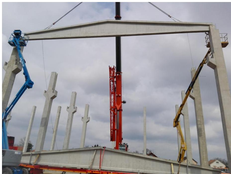
Slika 4.11. Montiranje glavnog krovnog grednog nosača pomoći auto dizalice
