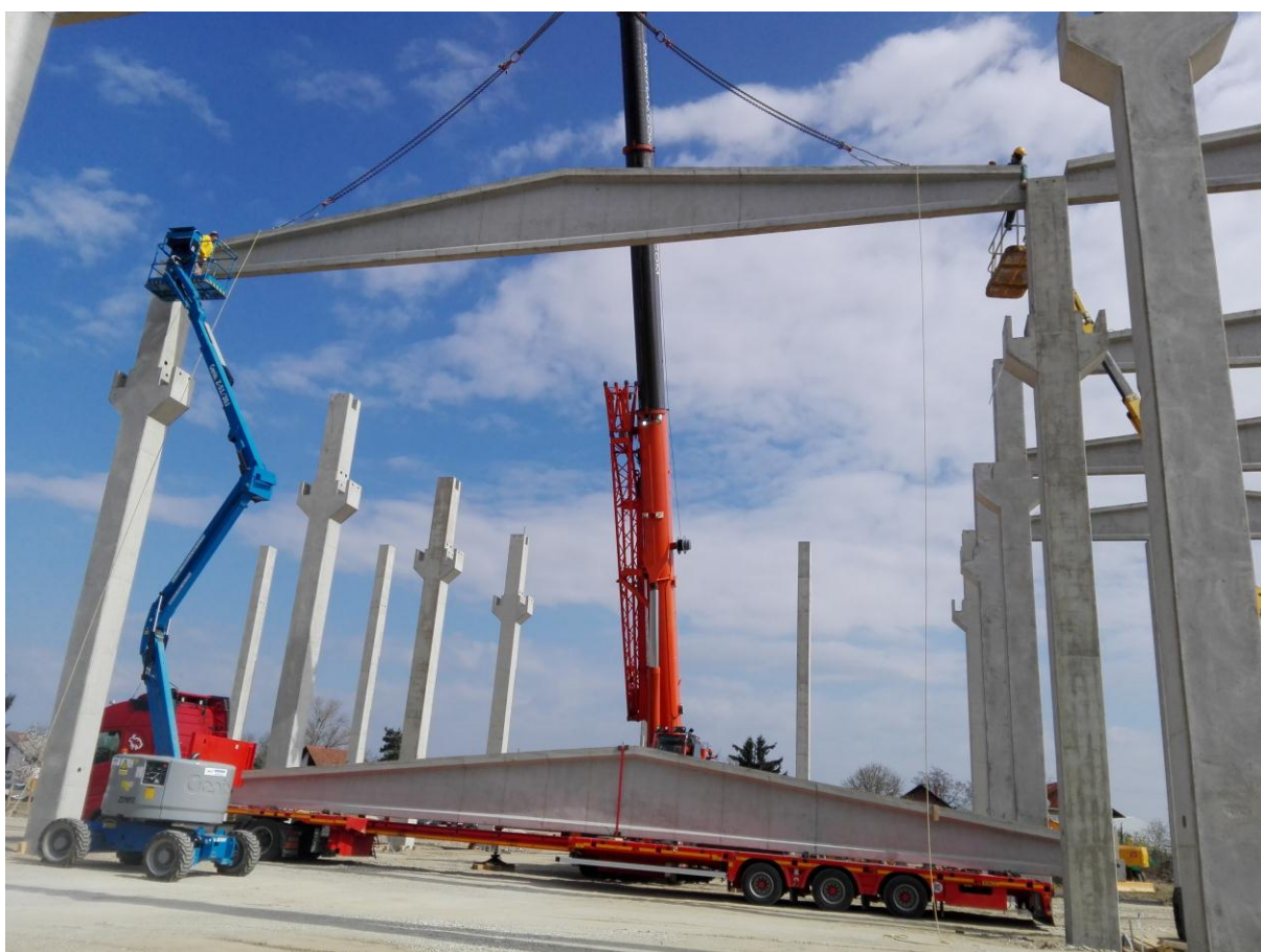
Slika 4.12. Montiranje glavnog krovnog grednog nosača pomoću auto dizalice
