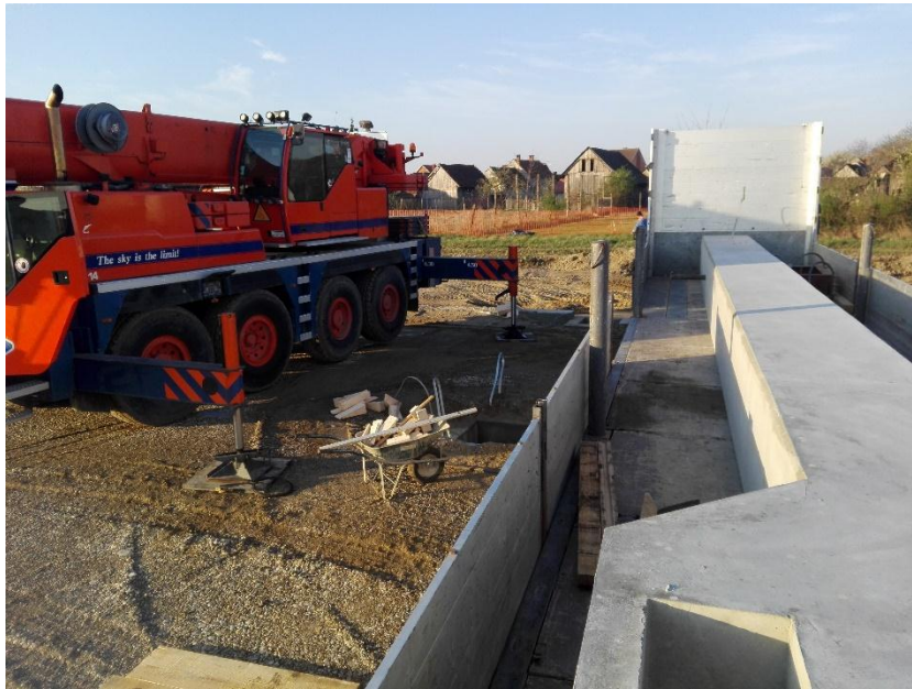
Slika 4.6. Doprema AB stupa na kamionu
