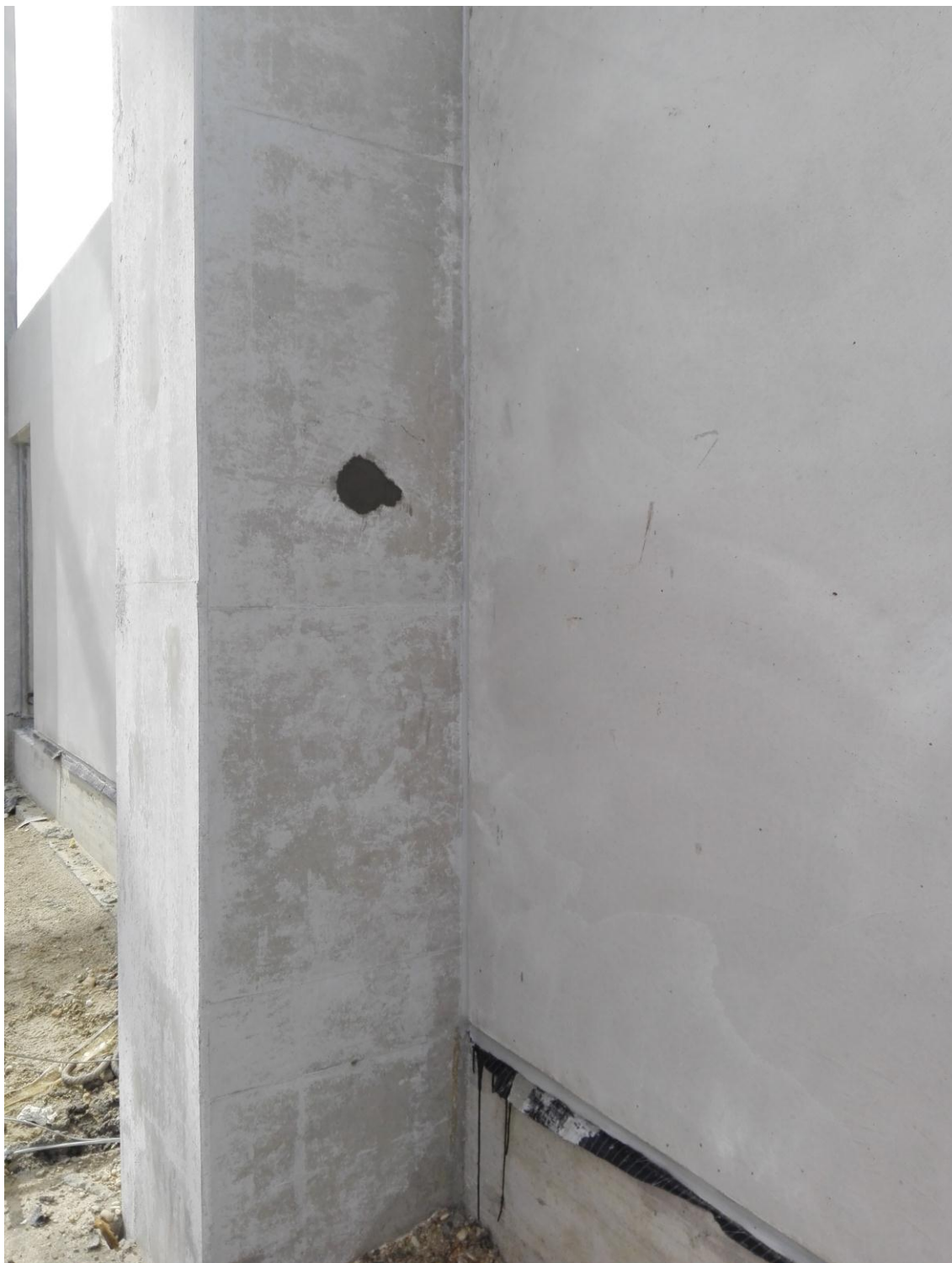
Slika 4.21. Zabetonirani otvor na AB stupu koji se koristio kod utovara i istovara AB elementa
