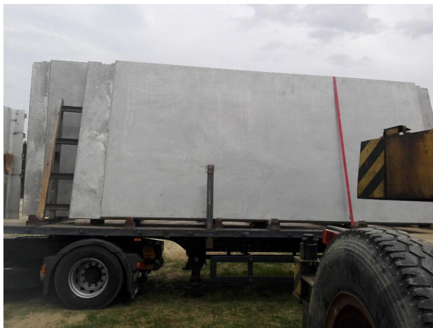
Slika 4.16. AB troslojni fasadni paneli na kamionu
