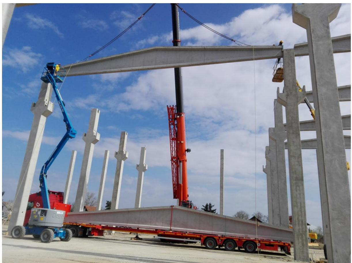
Slika 4.12. Montiranje glavnog krovnog grednog nosača pomoći auto dizalice
