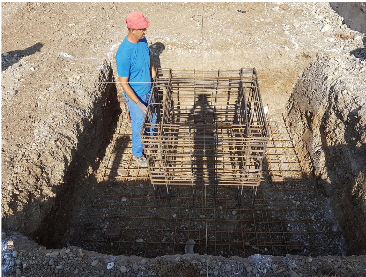
Slika 4.1. Armaturni koš za temeljne stope
