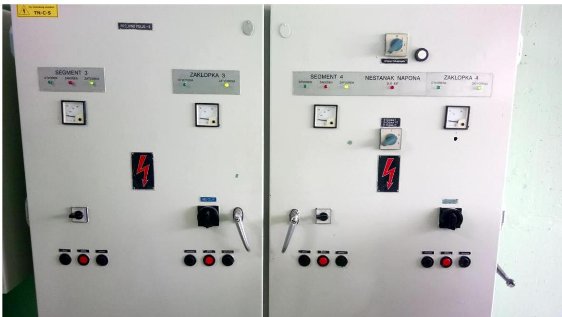
Slika 2.14. Upravljački ormari preljevnih polja
