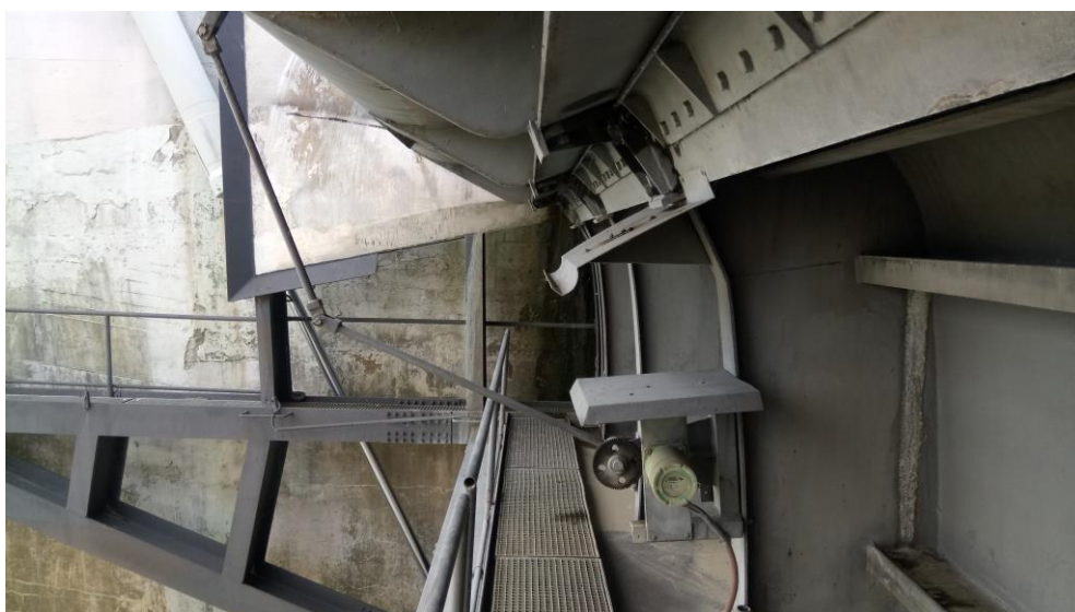
Slika 2.13. Sustav za mjerenje položaja zaklopke
