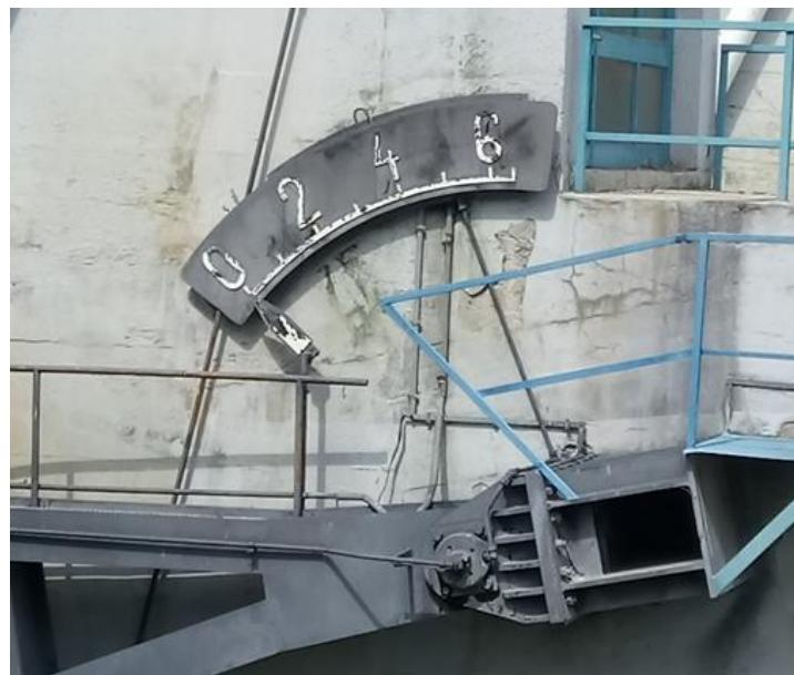
Slika 2.12. Vanjski, mehanički pokazivač položaja
