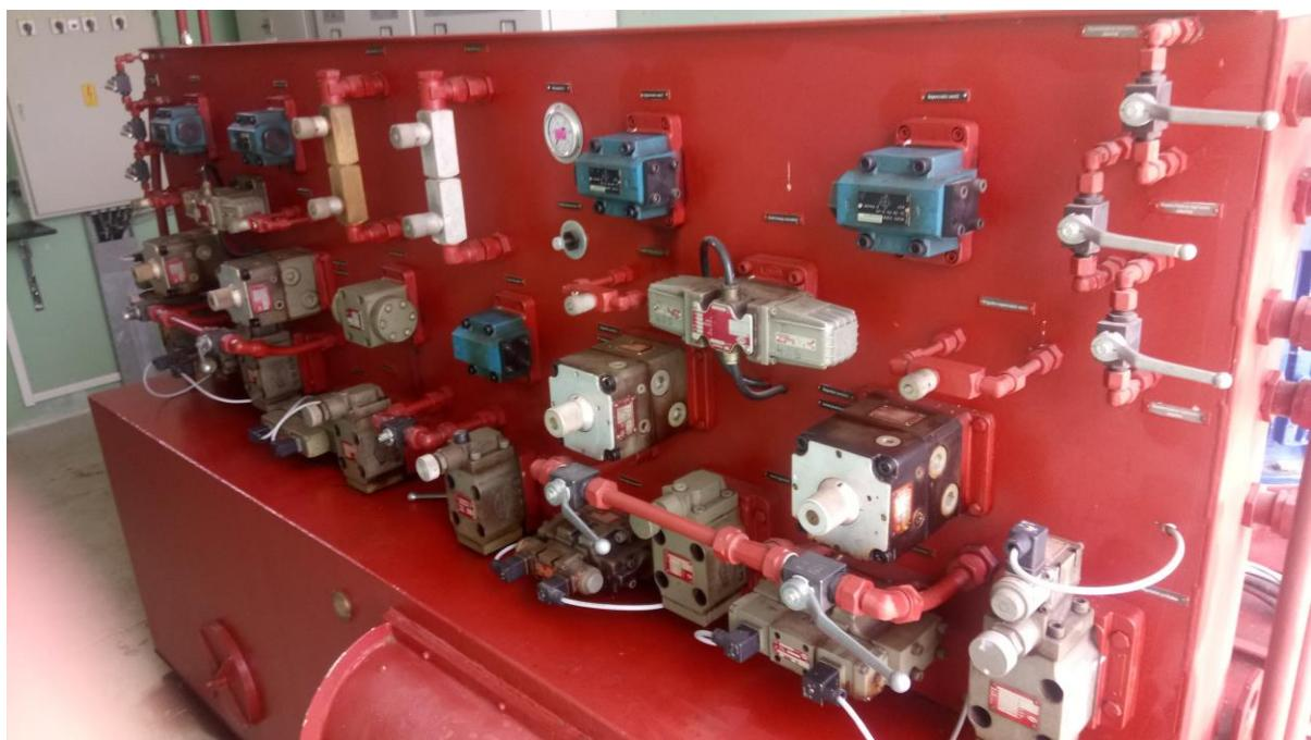
Slika 2.2. Hidraulični agregat za pokretanje preljevnih polja
