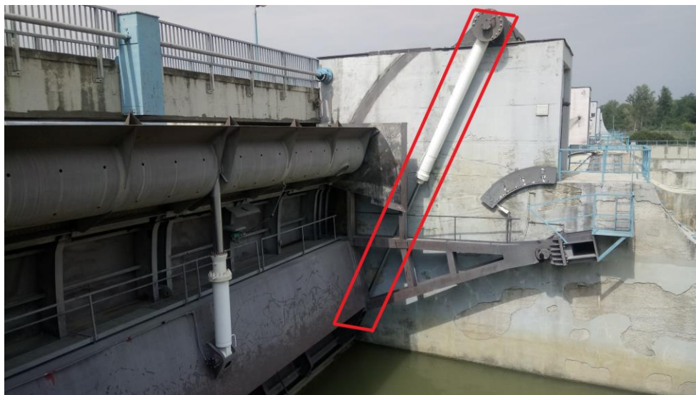
Slika 2.7. Preljevno polje, Servomotor segmentnog zatvarača
