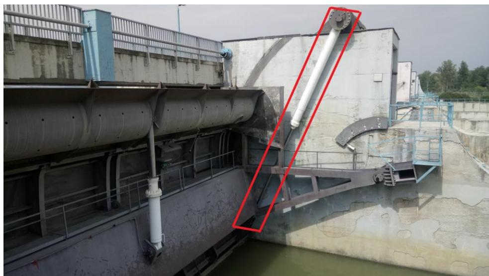
Slika 2.7. Preljevno polje, Servomotor segmentnog zatvarača
