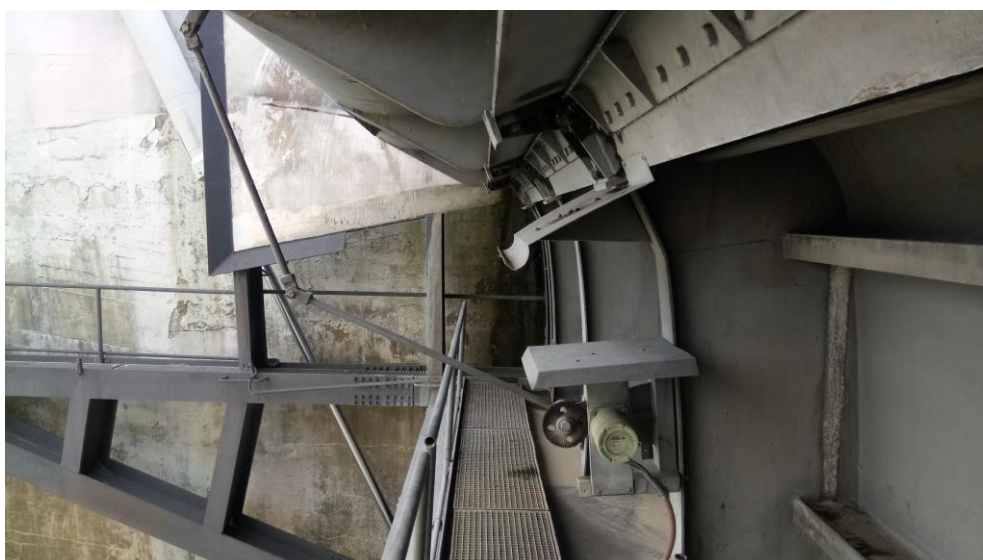
Slika 2.13. Sustav za mjerenje položaja zaklopke
