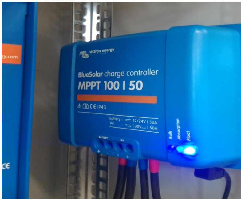
Slika 3.1 uređaj Victron Energy BlueSolar 100/50
