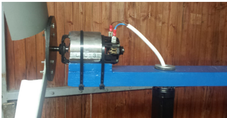
Slika 5.17 Montiranje generatora i postavljanje kabela
