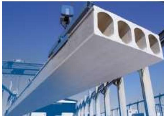
*Slika 1.1. Izgled elementa prednapregnute šuplje ploče*
