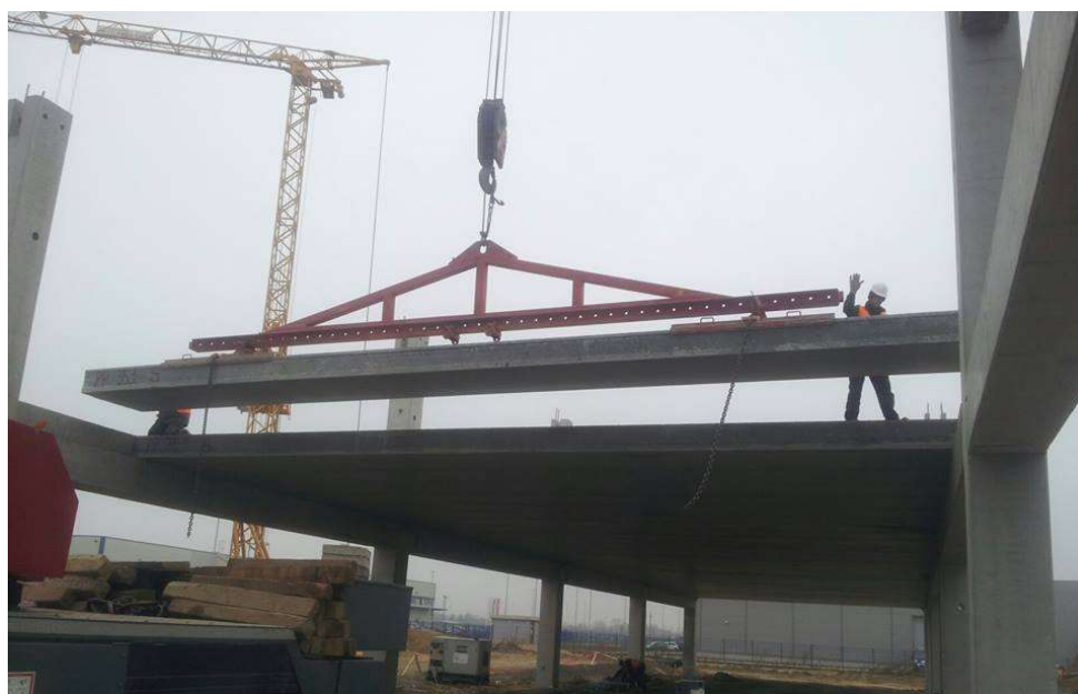
Slika 4.4. Spuštanje prednapregnutih ploča na oslonce
