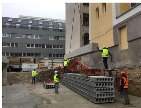
*Slika 4.2. Izgled trokutastog nastavka za podizanje prednapregnutih šupljih ploča*
