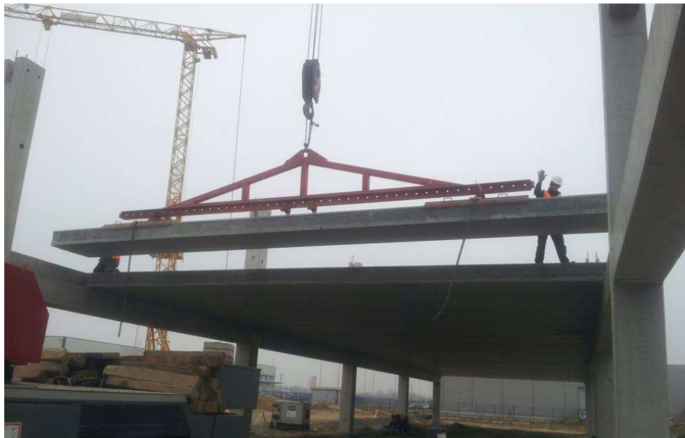
Slika 4.4. Spuštanje prednapregnutih ploča na oslonce
