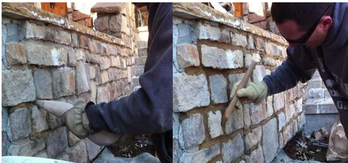
Slika 17. Fugiranje vrećicom i ručno zaglađivanje površine
