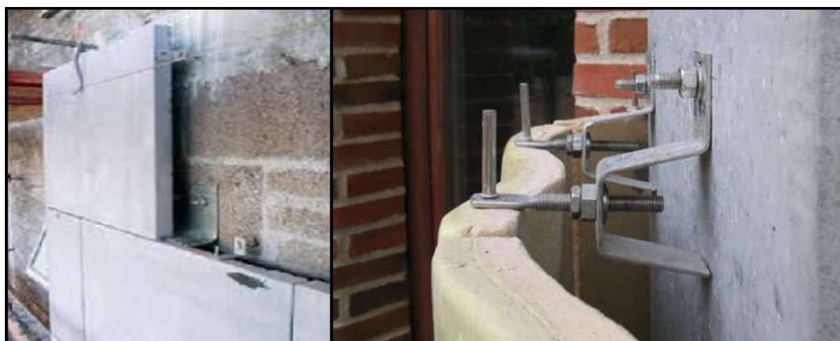
Slika 33. Postavljanje kamenih ploča na pročelje građevine
