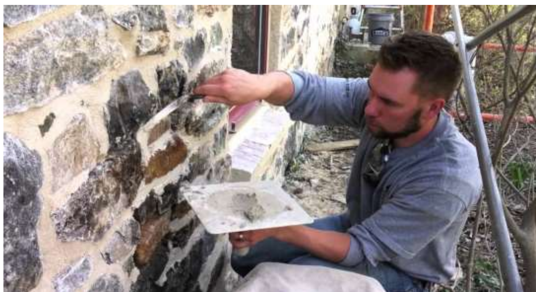
Slika 16. Zaglađivanje fuga sa žlicom
