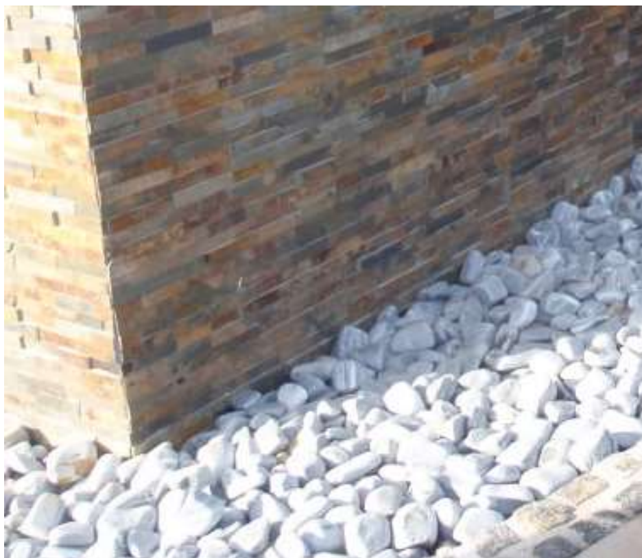
Slika 23. Drenažni sloj od oblutaka
