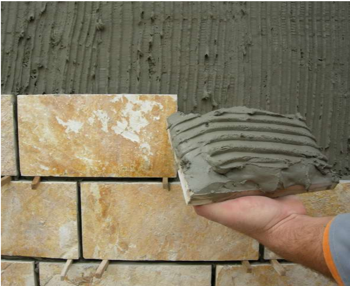
Slika 40. Oblaganje kamenim pločama
