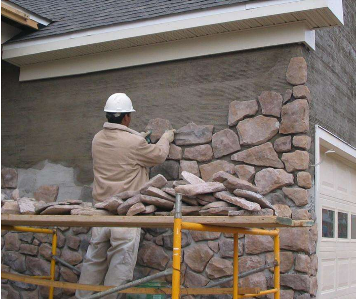
Slika 19. Postavljanje kamenih ploča na hrapavu površinu
