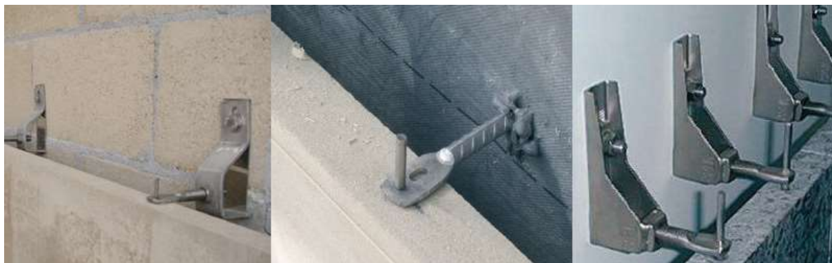
Slika 32. Kamena ploča učvršćena sidrima
