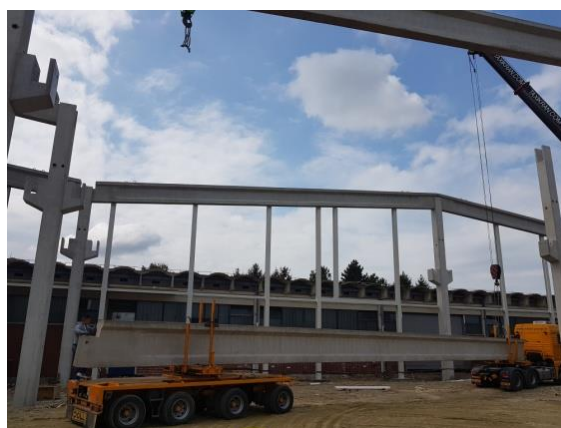
Slika 84. Priprema nosača za montiranje
