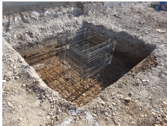
Slika 16. Postavljena armatura stope za stup
