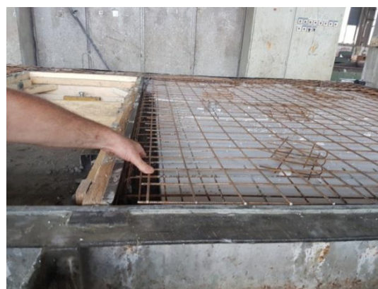
Slika 61. Armiranje AB fasadnog panela
