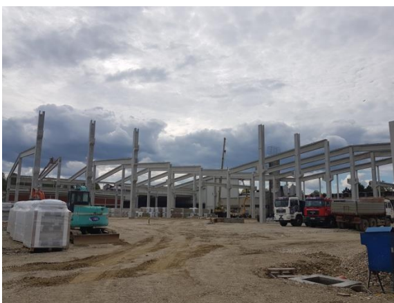
Slika 100 Trenutno stanje gradilišta
