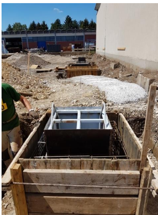
Slika 26. Postavljena oplata temeljne čašice stupa
