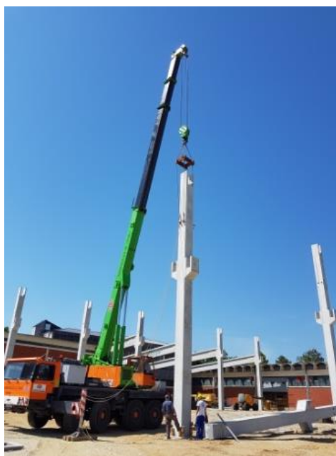
Slika 74. Postavljanje AB stupa u temeljnu čičašu
