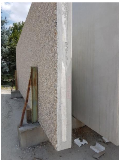
Slika 64. Skladišten AB fasadni panel prije otpreme
