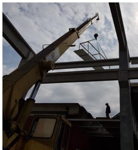
Slika 86. Montiranje pokrovnih panela
