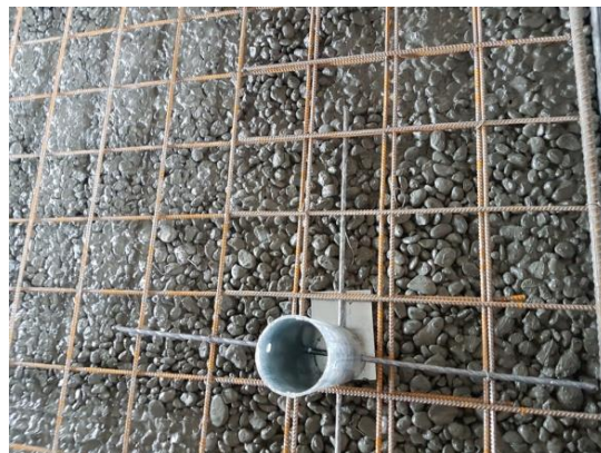
Slika 63. Pocinčana veza između slojeva fasade
