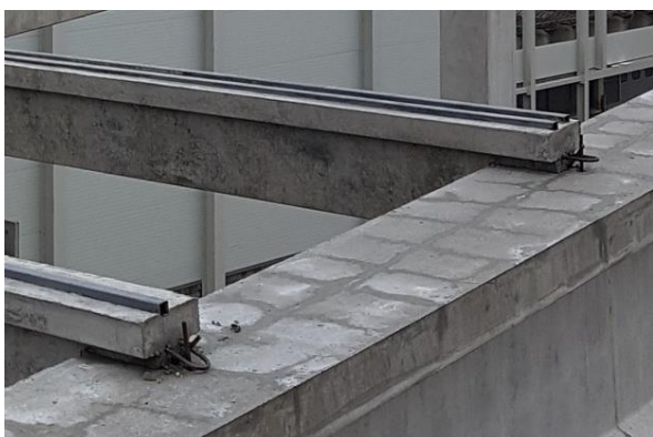
Slika 97 Vidljiv spoj sekundarnog nosača i klina
