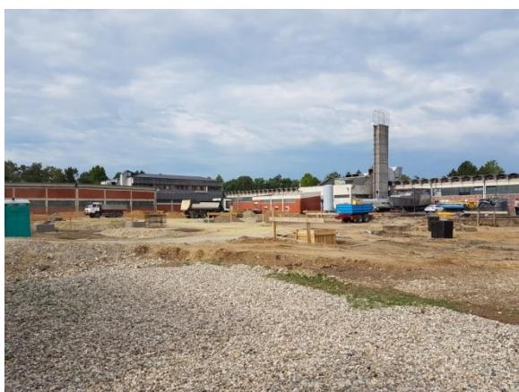
Slika 99 Gradilište na početku građenja
