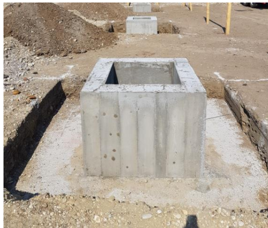
Slika 30. Prikaz gotove temeljne stope i temeljne čašice
