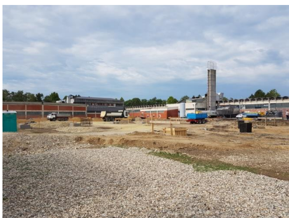
Slika 99 Gradilište na početku građenja
