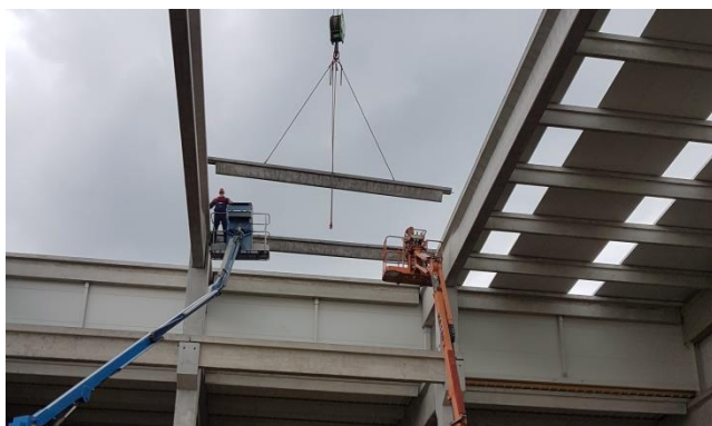
Slika 91. Montiranje krovnog sekundarnog nosača
