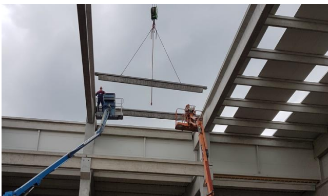
Slika 91. Montiranje krovnog sekundarnog nosača
