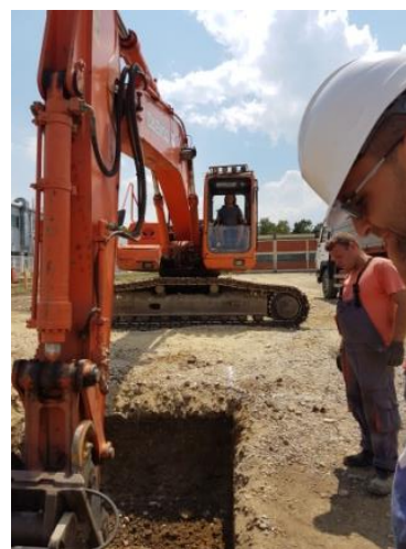
Slika 14. Iskop temeljne stope bagerom
