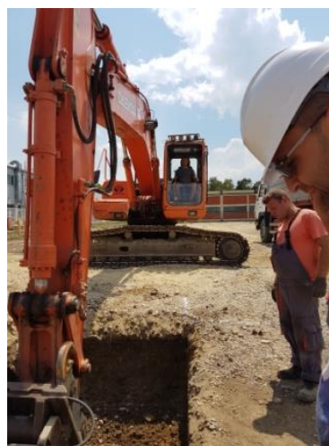
Slika 14. Iskop temeljne stope bagerom
