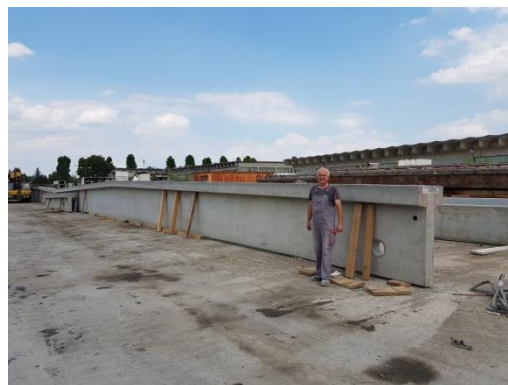
Slika 59. Skladištenje A nosača prije otpreme na montažu
