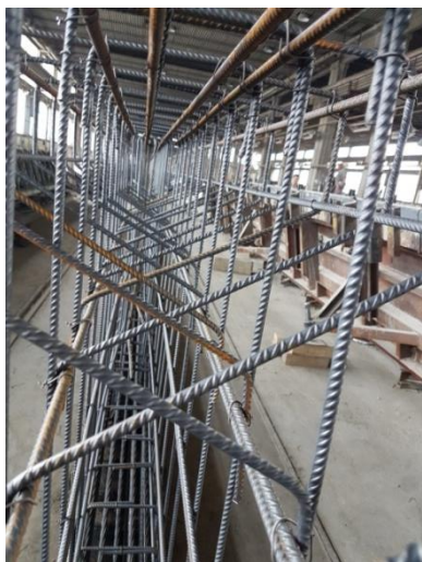
Slika 56. Armatura nosača
