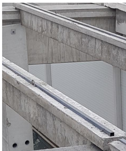
Slika 93. Montažne kuke na sekundarnom nosaču
