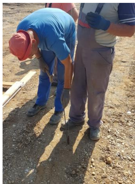
Slika 12. Viskovanje prije iscrtavanja temeljne stope
