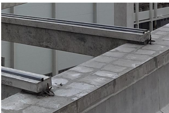
Slika 97 Vidljiv spoj sekundarnog nosača i klina
