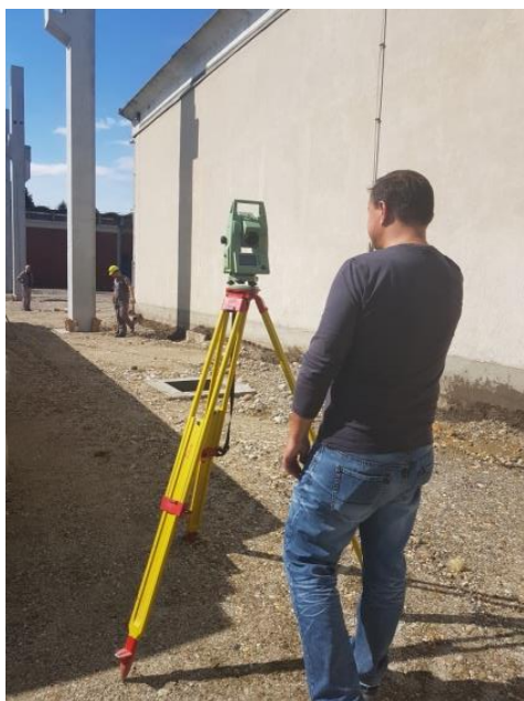
Slika 77. Određivanje vertikalnosti stupa pomoću teodolita
