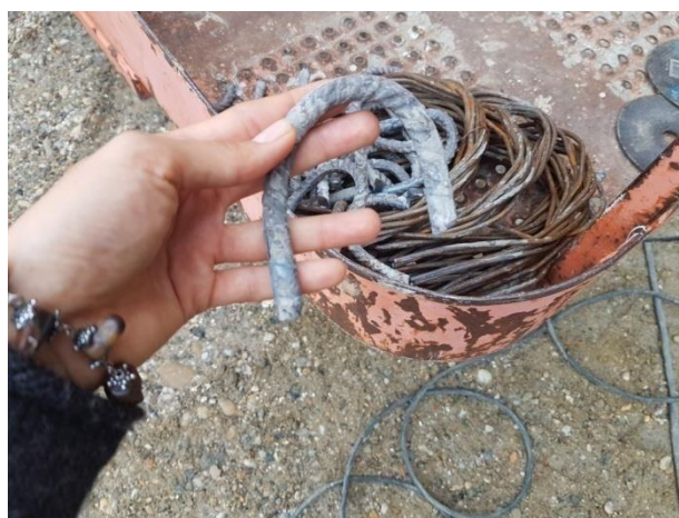
Slika 94. Odstranjena kuka sa sekundarnog nosača
