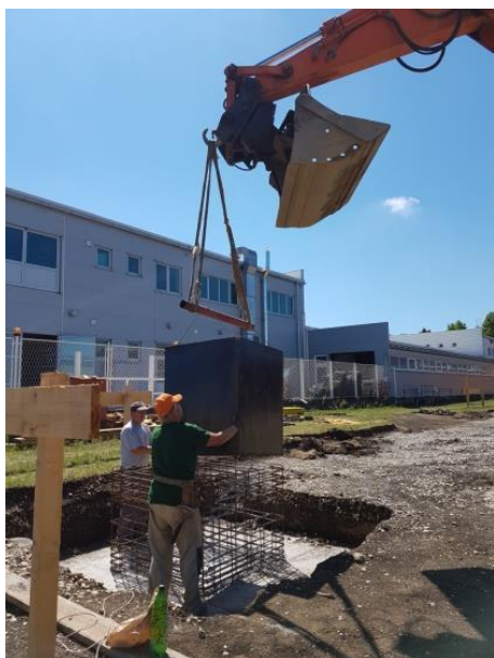
Slika 23. Postavljanje unutarnje oplata temeljne čašice stupa
