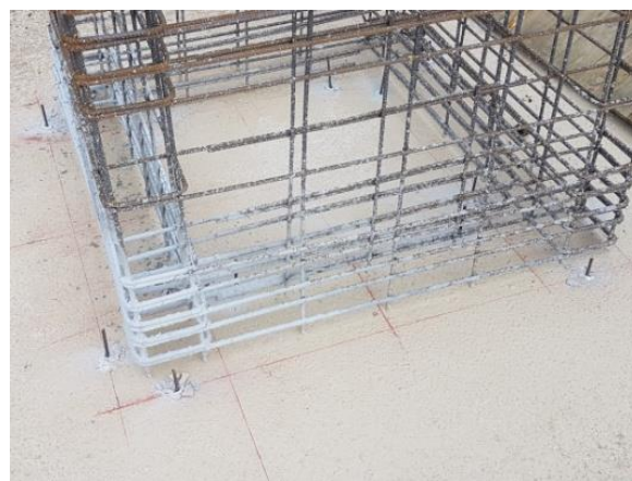
Slika 22. Iscrtane linije za postavu opate temeljne čašice stupa
