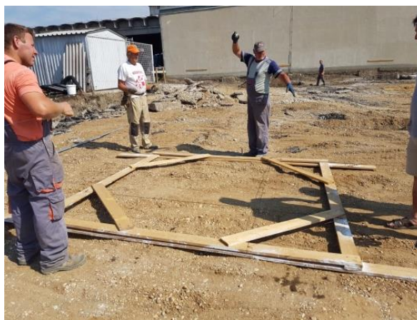
Slika 10. Iscrtavanje temeljne stope za potrebe strojnog iskopa
