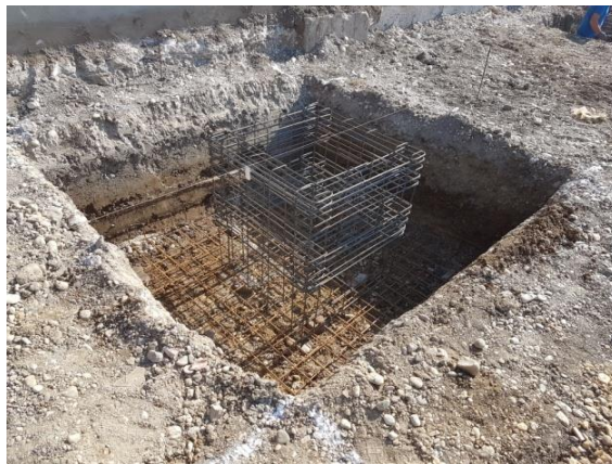
Slika 16. Postavljena armatura stope za stup
