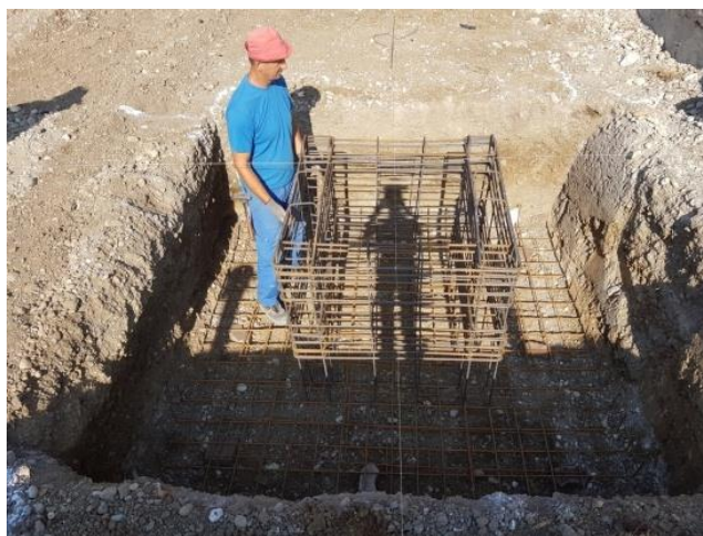
Slika 18. Centrirana armatura temeljne čašice
