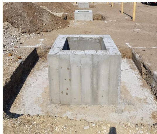
Slika 30. Prikaz gotove temeljne stope i temeljne čašice
