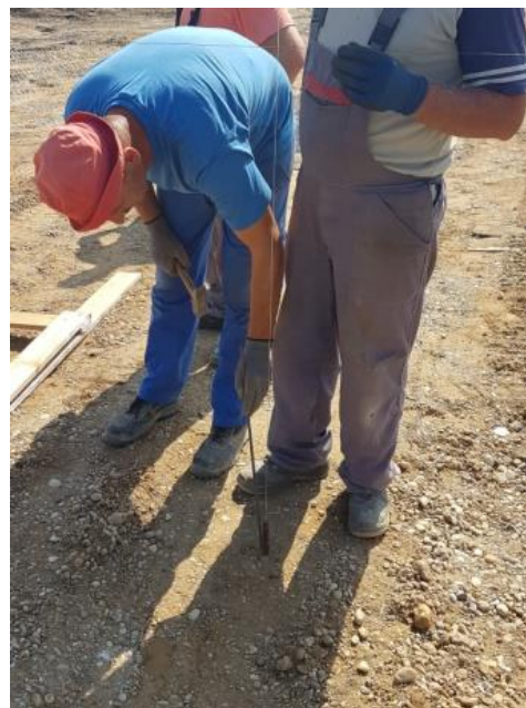
Slika 12. Viskovanje prije iscrtavanja temeljne stope
