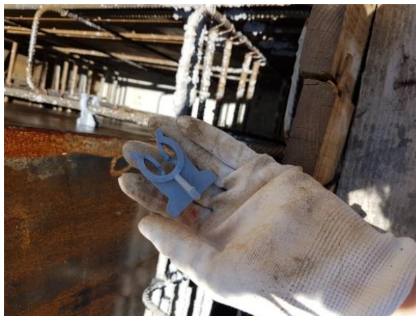
Slika 24. Točkasti distancer za armaturu
