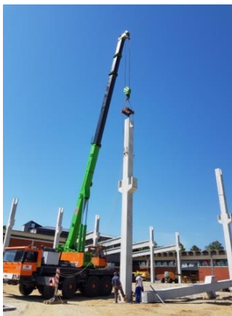
Slika 74. Postavljanje AB stupa u temeljnu čašu
