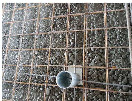
Slika 63. Pocinčana veza između slojeva fasade
