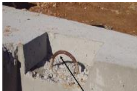
Slika 50. Pomoćna sredstva za prihvaćanje elemenata
