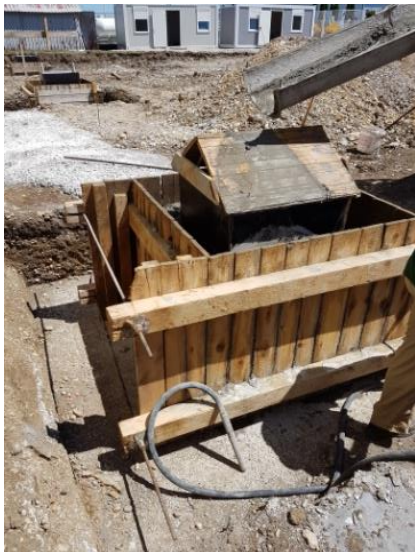
Slika 27. Početak betoniranja temeljne čašice
