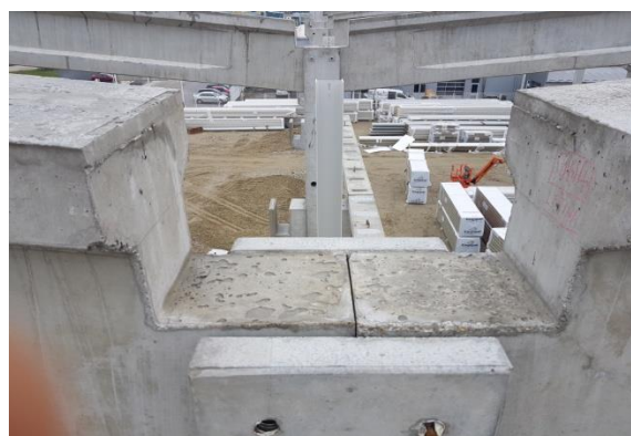
Slika 98 Montirani glavni nosači na vrhu stupa
