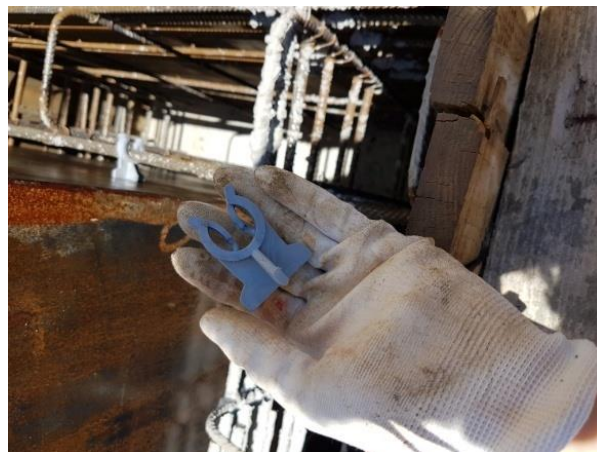
Slika 24. Točkasti distancer za armaturu
