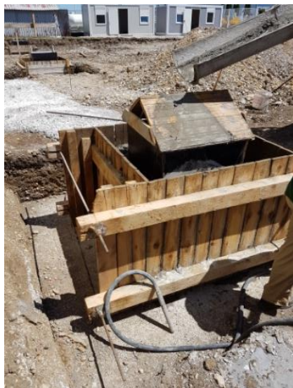
Slika 27. Početak betoniranja temeljne čašice
