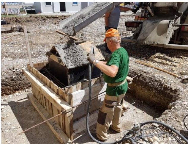
Slika 28. Vibriranje vibro iglom prilikom ugradnje betona
