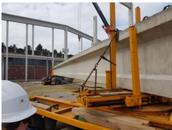
Slika 83. Doprema prefabriciranog krovnog nosača na kamionu
