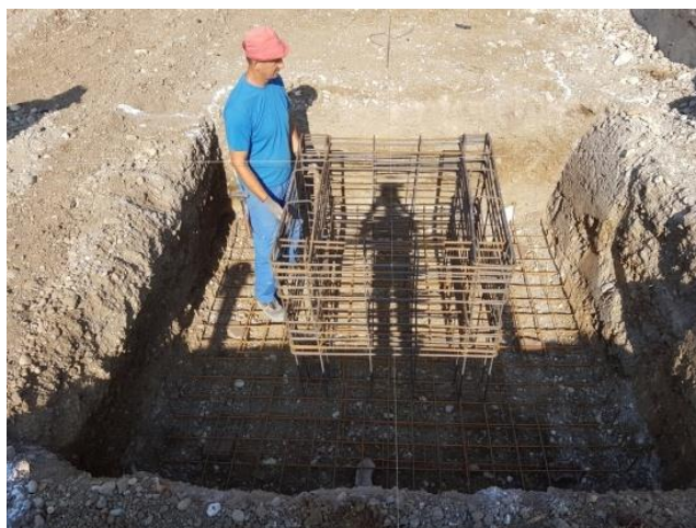
Slika 18. Centrirana armatura temeljne čašice
