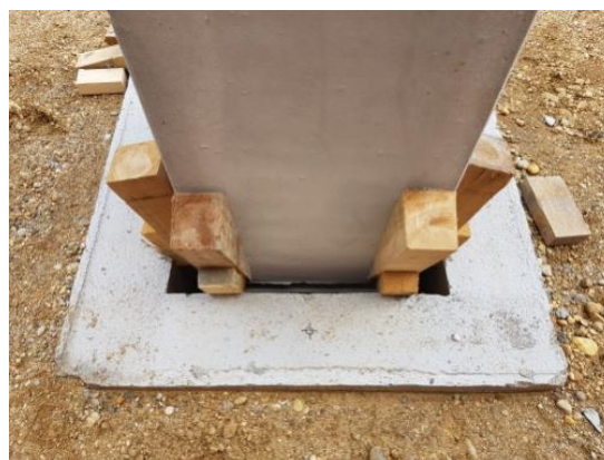
Slika 76. Centriran AB stup pomoću drvenih klinova
