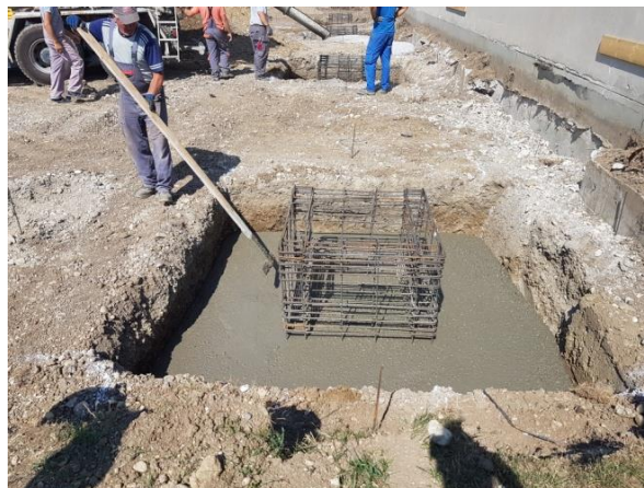
Slika 20. Poravnavanje betona nakon betoniranja
