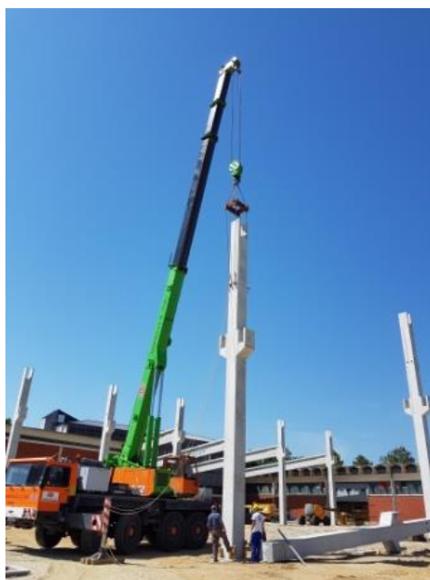
Slika 74. Postavljanje AB stupa u temeljnu čašu
