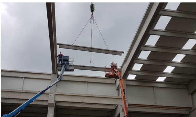
Slika 91. Montiranje krovnog sekundarnog nosača
