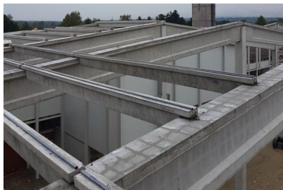
Slika 96 Montirani sekundarni nosači
