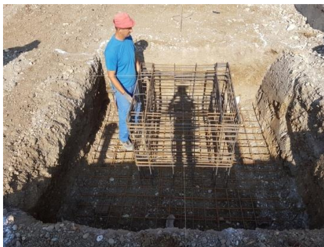
Slika 18. Centrirana armatura temeljne čašice
