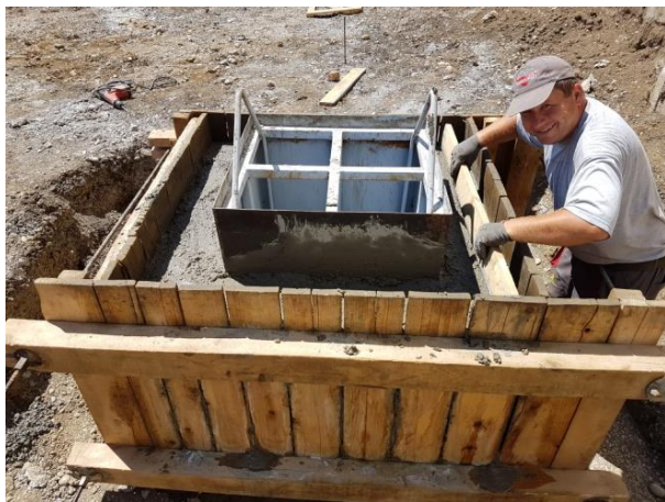
Slika 29. Ravnanje betona temeljne čašice nakon za stup betoniranja
