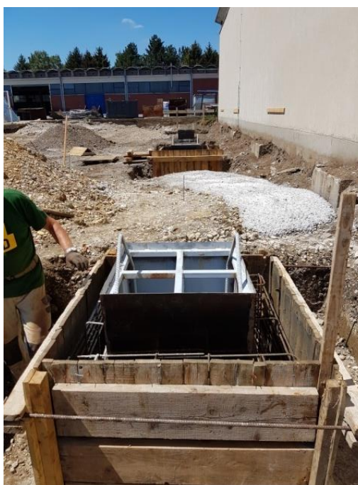
Slika 26. Postavljena oplata temeljne čašice stupa
