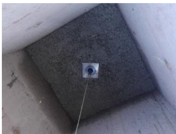
Slika 70. Postavljanje čašica u centar osi temeljnih ploča pomoću viska i geodetskih oznaka
