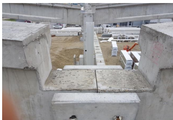
Slika 98 Montirani glavni nosači na vrhu stupa
