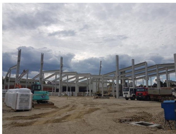
Slika 100 Trenutno stanje gradilišta
