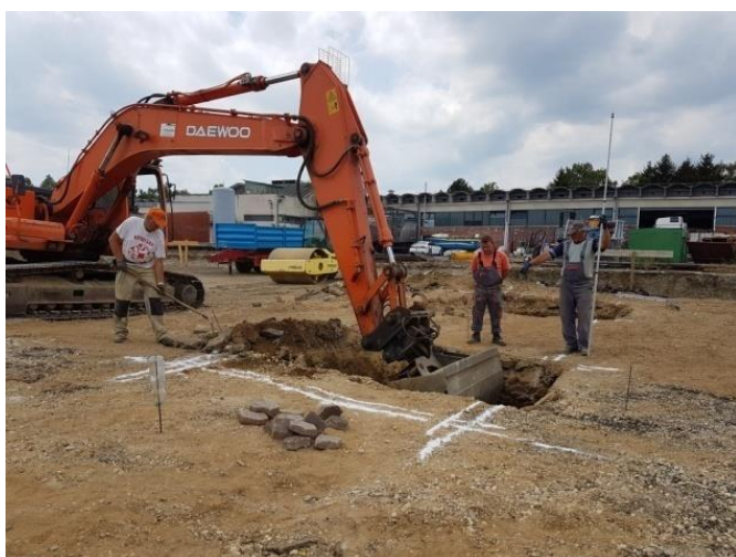
Slika 13. Iskop temeljne stope bagerom
