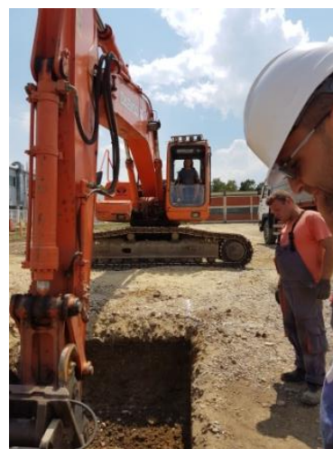
Slika 14. Iskop temeljne stope bagerom
