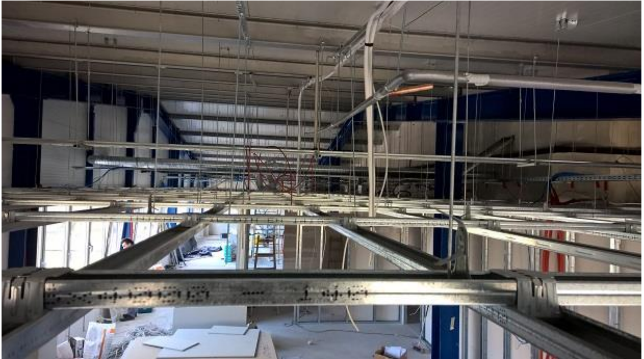
Slika 5.7. Dupla metalna podkonstrukcija ovješena na sidreni ovjes
