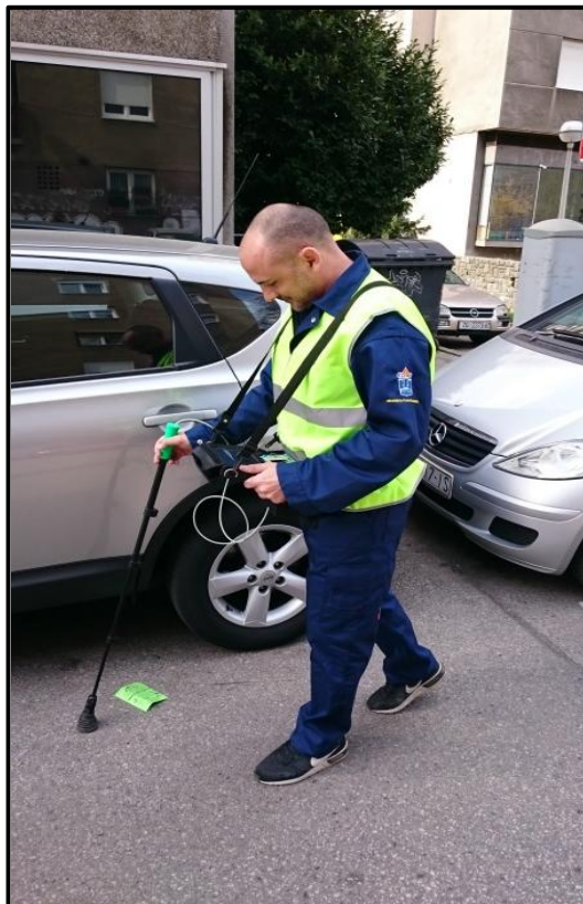
Slika 4.6 Prikaz ispitivanja nepropusnosti operativnih ekipa na terenu
