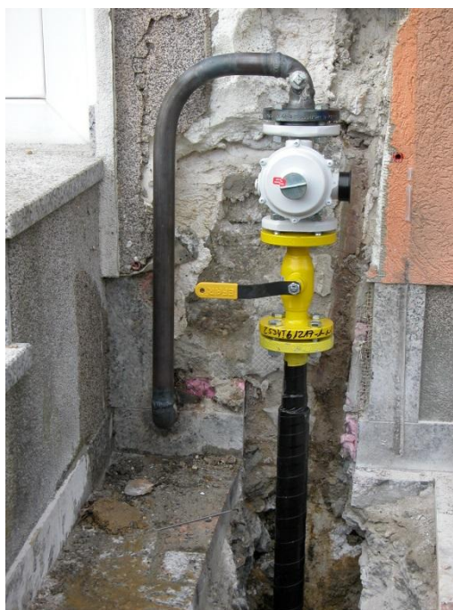
Slika 5.5 Prikaz spojnog seta nakon sanacije izlaza plina
