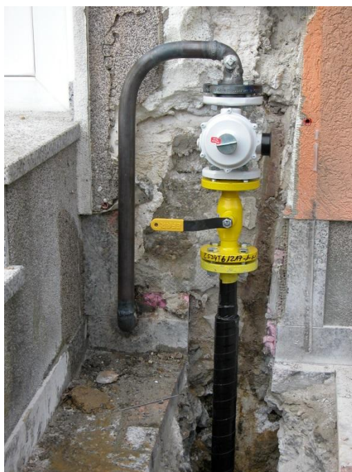
Slika 5.5 Prikaz spojnog seta nakon sanacije izlaza plina
