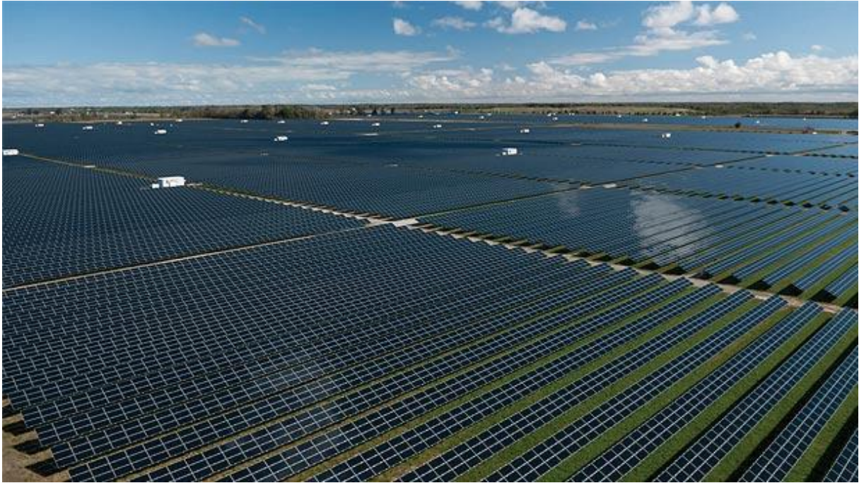
Slika 4.1. Solarna elektrana Topaz u Kaliforniji [44]
