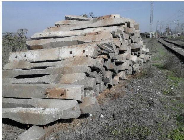
Slika 23. Deponija starih betonskih pragova u kolodvoru Vinkovci [13]
