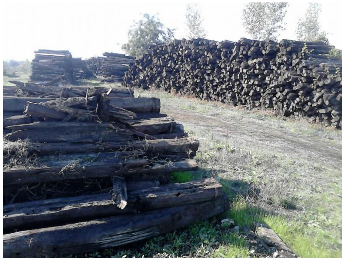
Slika 17. Deponija drvenih pragova III kategorije u kolodvoru Vinkovci [13]
