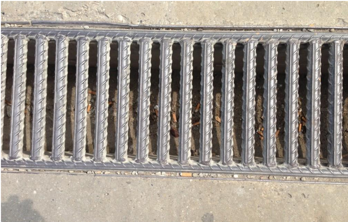
Slika 20. Linijski rešetkasti slivnik
