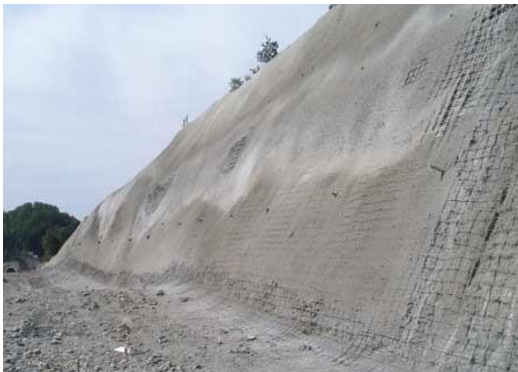
Slika 11. Primjena mlaznog betona za zaštitu kosina
