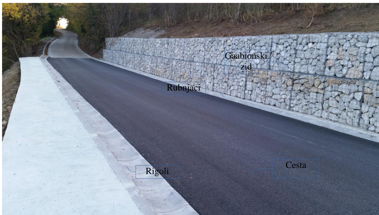
Slika 26. Izvedbeni gabionski zid ispod (preko kojeg je betonirana AB ploča) i iznad ceste
