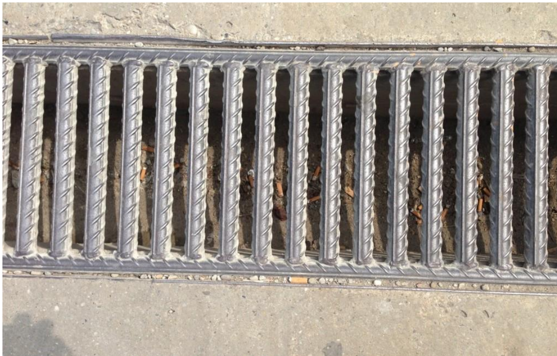
Slika 20. Linijski rešetkasti slivnik
