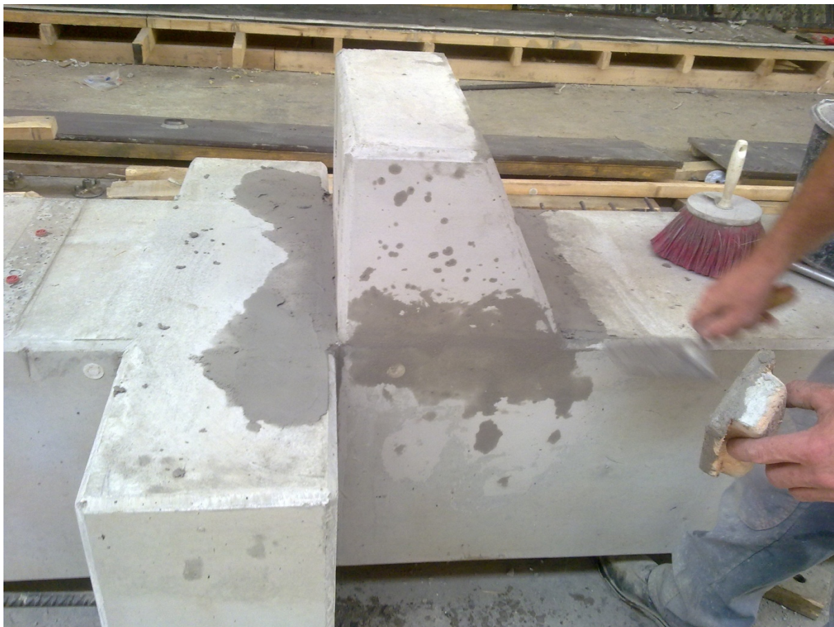
Slika 9: Sanacija gotovog elementa AB stupa
