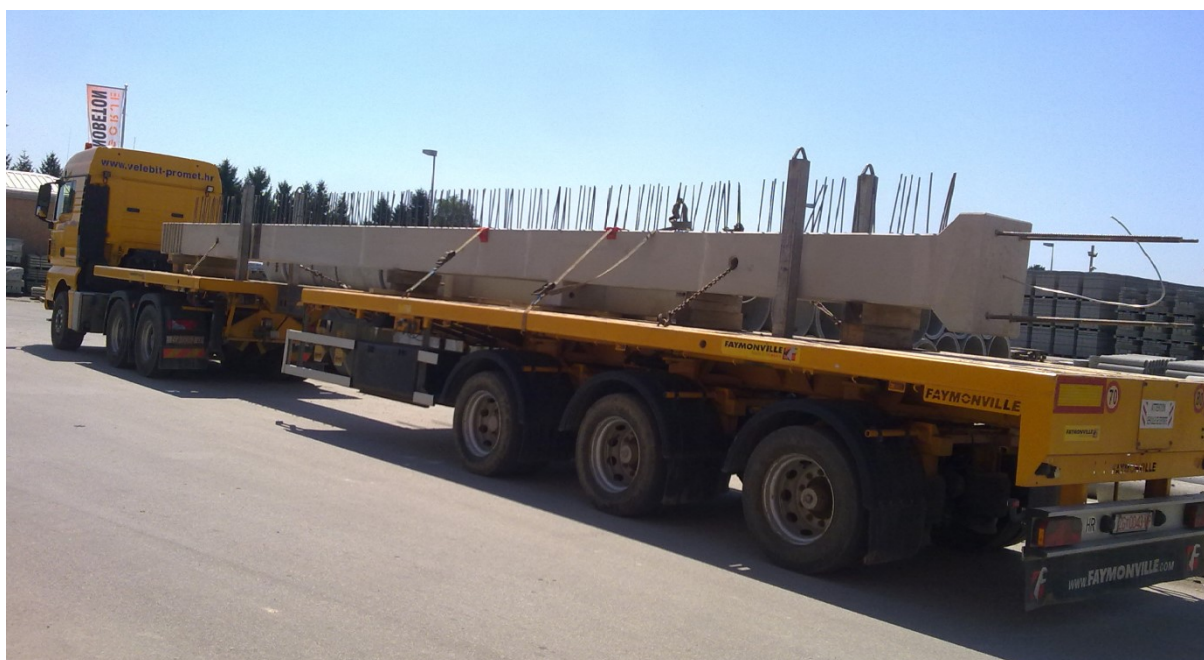
Slika 11: Transport gotovog predgotovljenog armiranobetonskog elementa- stupa
