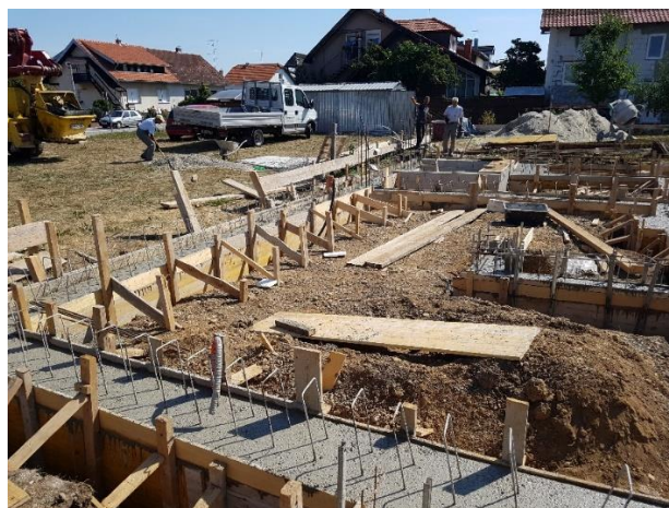
Slika 3.18. Prikaz oplata trakastih temelja
