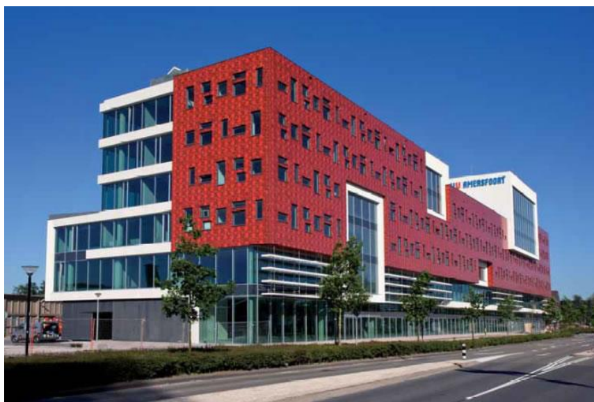
Slika 7.8. Fasada od keramičkih pločica
