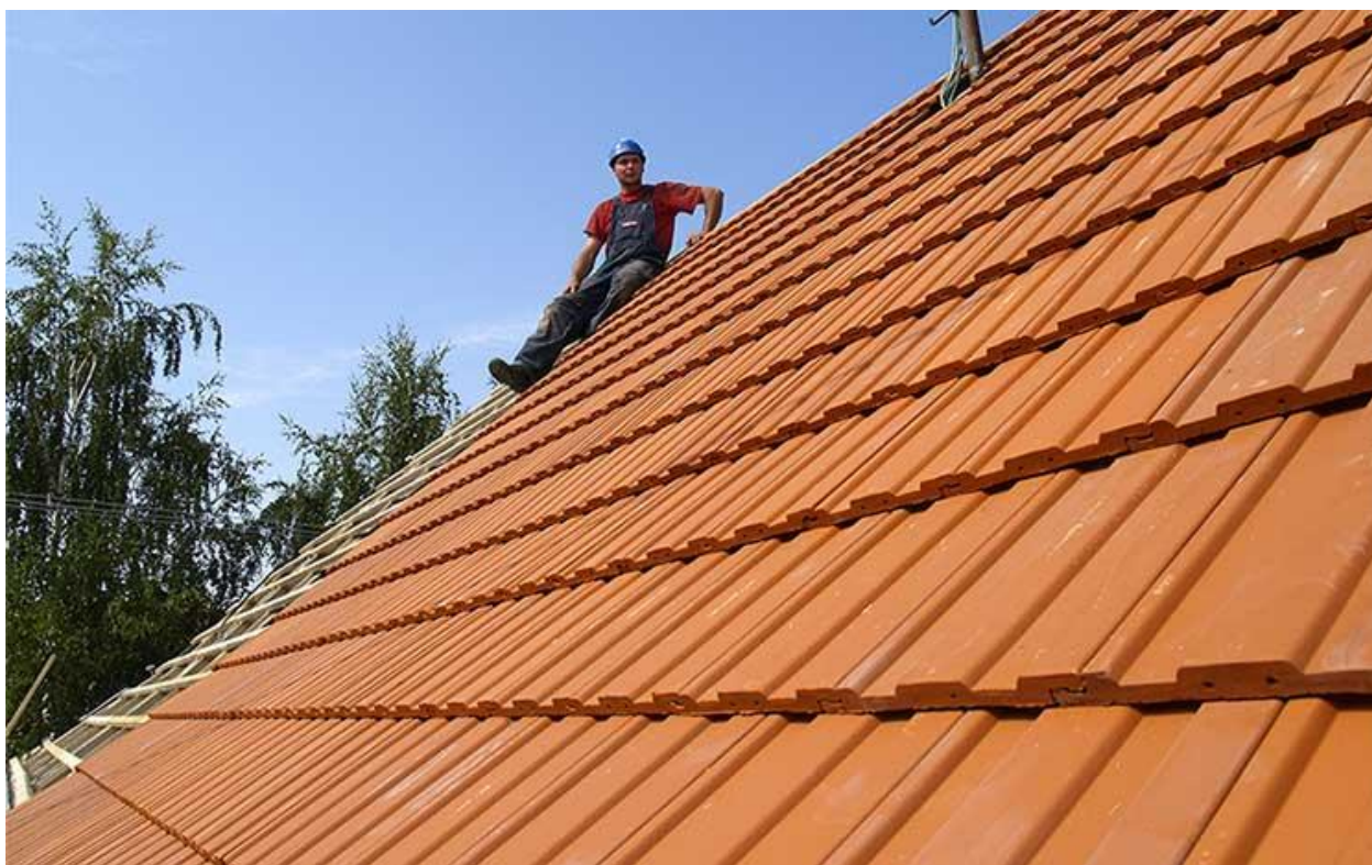
Slika 7.9. Postavljanje TONDACH crijepa
