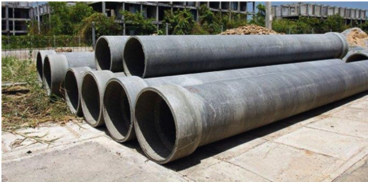
Slika 3.9. Azbestne vodovodne cijevi
