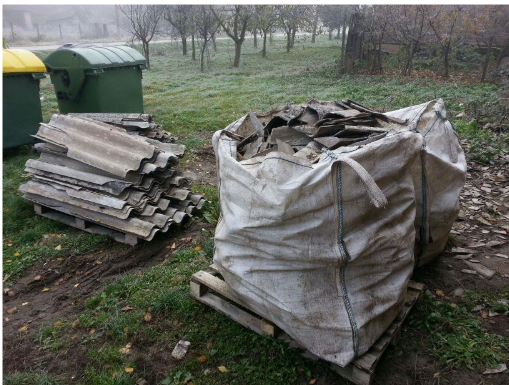
Slika 5.1. Velike vreće („big bag“) s azbestnim otpadom
