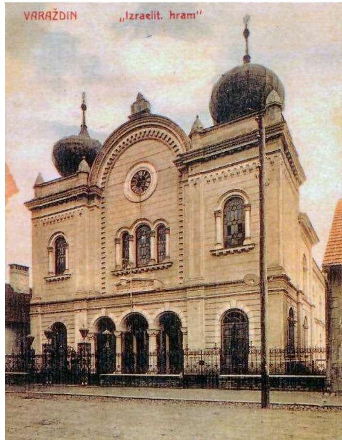
Slika 1.1. Prvomi izgled pročelja varaždinske sinagoge. Pogled sa sjevera. Izvor: razglednica, Gradski muzej Varaždin
