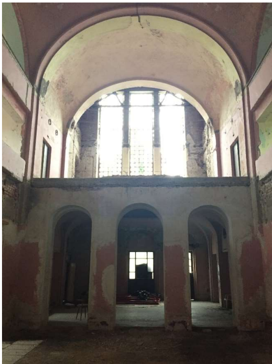
Slika 3.11. Pogled na tri jednaka ostakljena visoka otvora koji su u potpunosti izmjenili izvorni oblik sjevernog pročelja. Fotografirala: Ana Bašić
