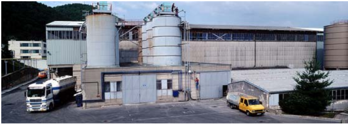
Slika 22. Dovoz i skladištenje sirovina u silose
