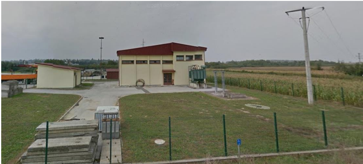
Slika 7 Trafostanica 35/10 kV u građevinskom obliku, Koprivnica
