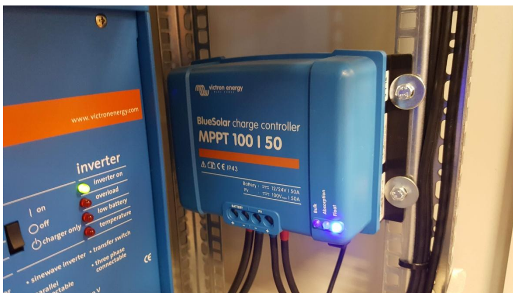
Slika 3.2 Regulator punjenja Victron Energy BlueSolar 100/50
