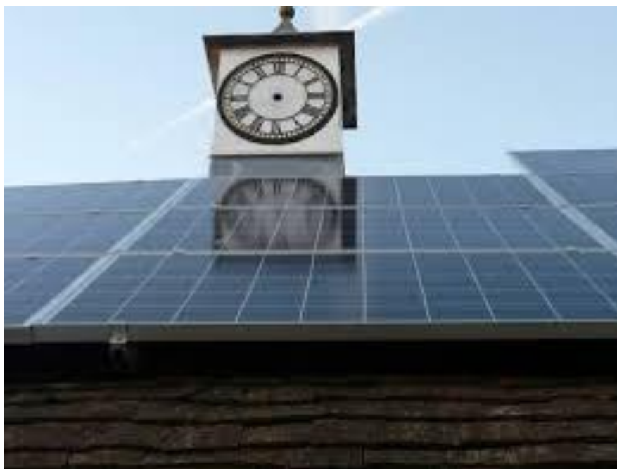
Slika 6. Zasjenjenje fotonaponskih modula stranim tijelom [7]
