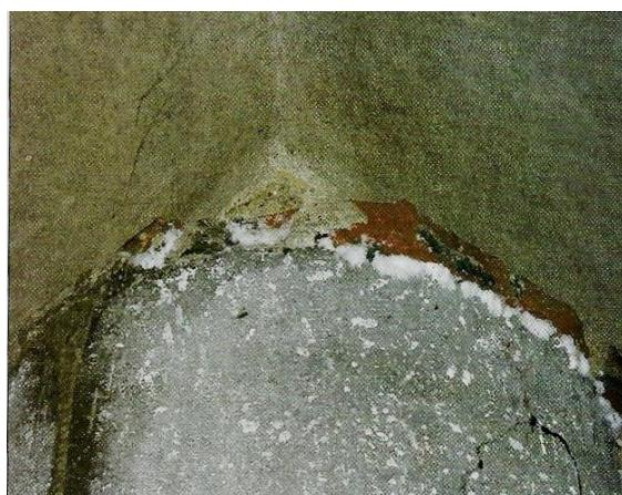
Slika 25. Prikaz isoljavanja na površinu stupa
