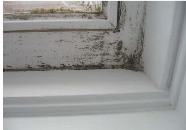
Slika 12., 13. Kondenzacija i plijesan na donjem rubu prozora
