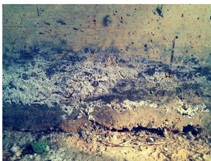
Slika 4. Kristalizacija soli na betonskom zidu
