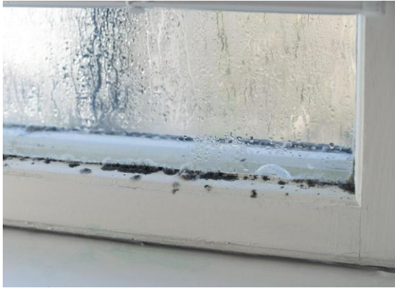
Slika 12., 13. Kondenzacija i plijesan na donjem rubu prozora
