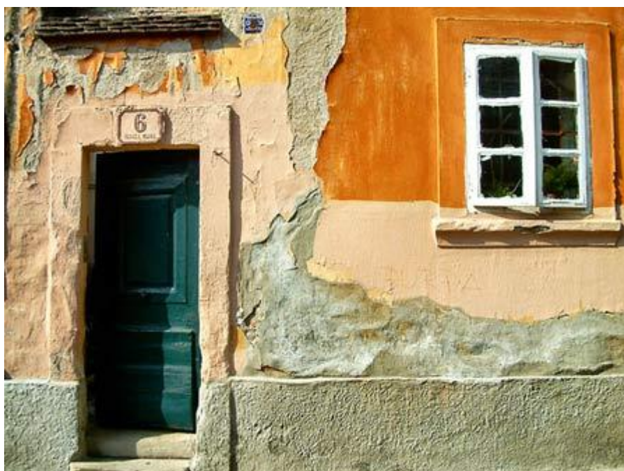
Slika 3. Kapilarna vlaga
