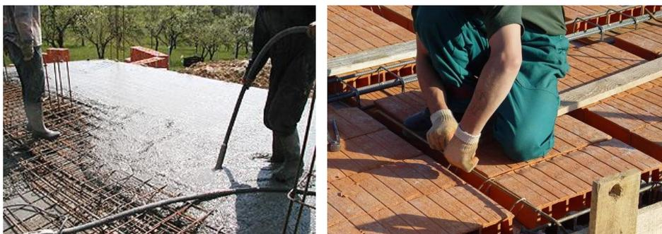
*Slika 1.3 Monolitna armiranobetonska ploča i polumontažni rebrasti strop*
