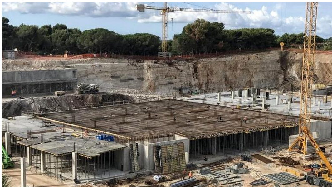
Slika 1. 1 Segment ploče uoči betonaže
