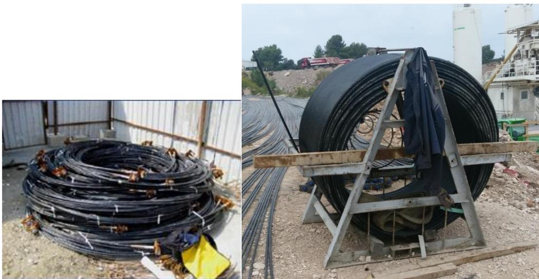
*2.5 Kabeli tvornički proizvedeni u kolutima ( unbonded princip)*
