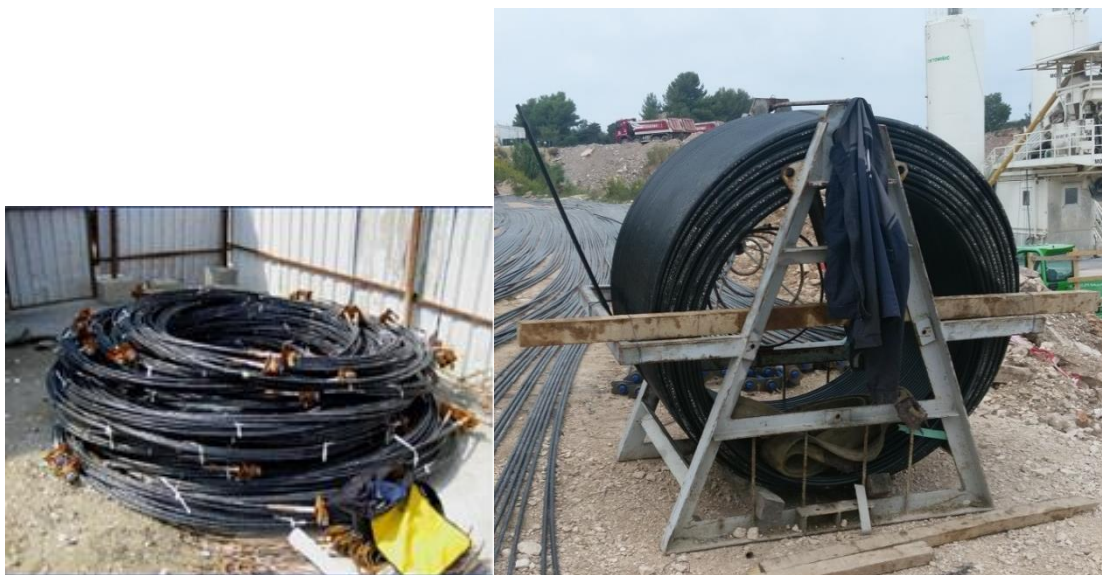
2.5 Kabeli tvornički proizvedeni u kolutima ( unbonded princip)
