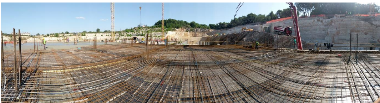
Slika 4.3 Panoramski prikaz betoniranja segmenta PT ploče
