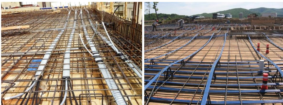
*Slika 2.7 Primjer ploče s „bonded“ i „unbonded“ kabelima*
