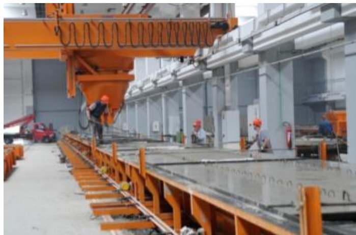
Slika 8. Betoniranje ploče u tvornici za predgotovljene betonske elemente
