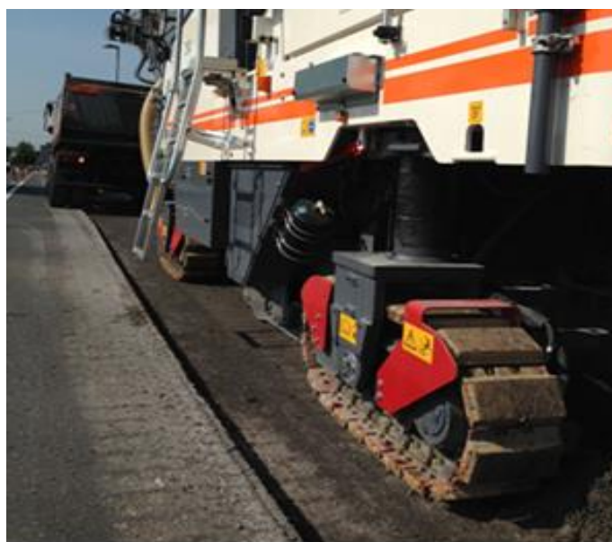
Slika 16. Glodanje starog asfaltnog sloja (izvor: baza podataka Zagrebačke ceste)
