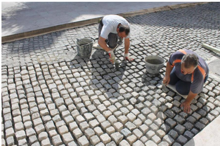
Slika 12. Postavljanje male kamene kocke (izvor: http://m.sibenik.in )
