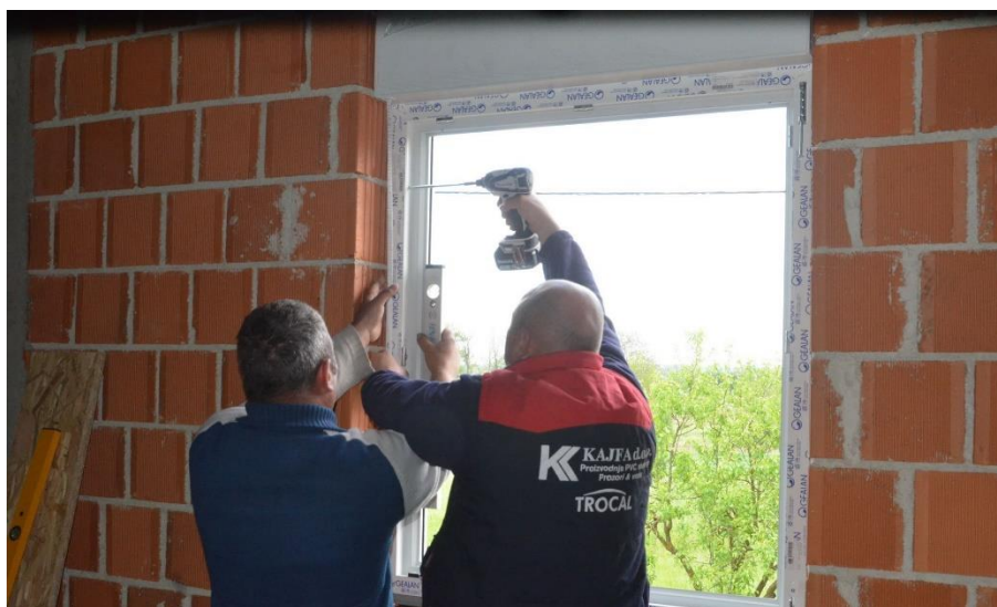
Slika 17. Ugradnja PVC prozora
