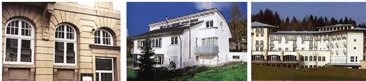
Slika 11. Primjeri ugrađenih prozorskih sustava na obiteljskim objektima
