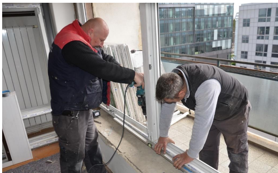
Slika 18. Montaža PVC balkonskih prozora i vrata
