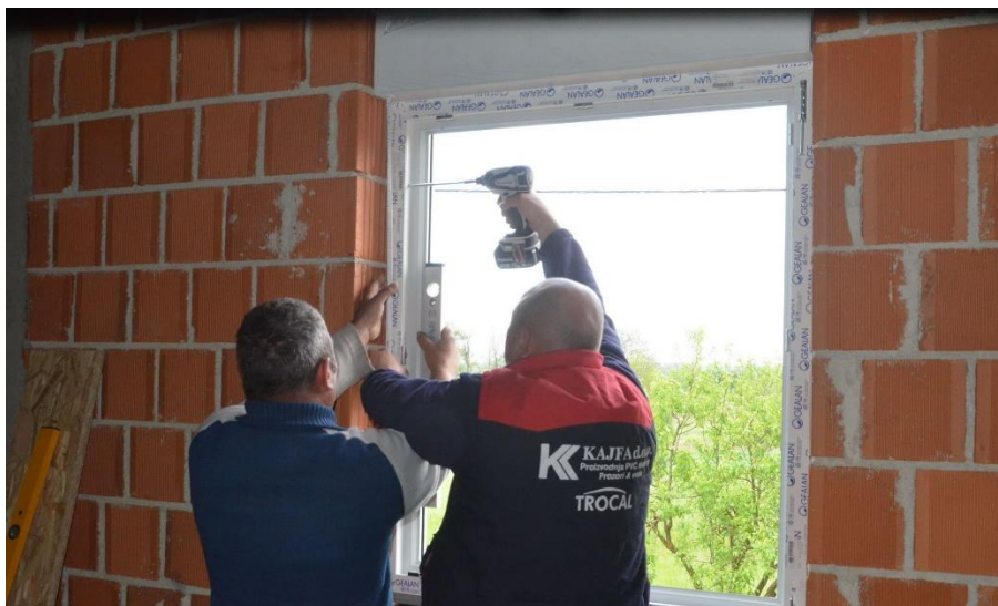
Slika 17. Ugradnja PVC prozora
