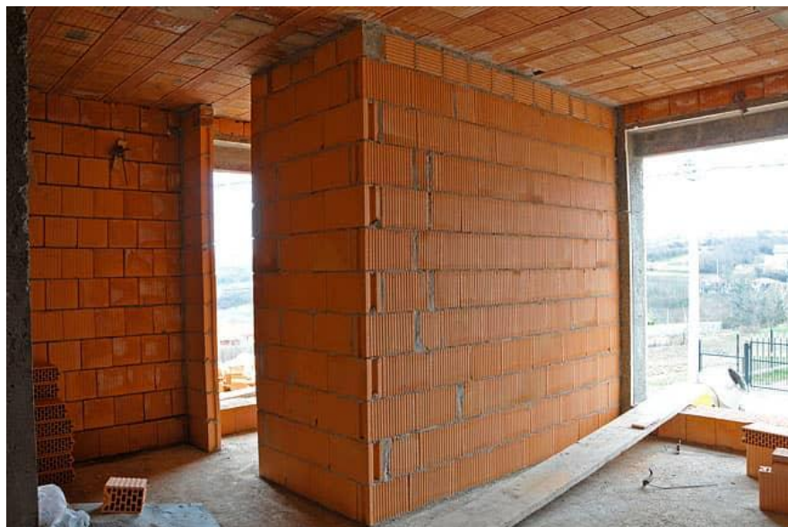
Slika 4.8. Zidanje pregradnih zidova
