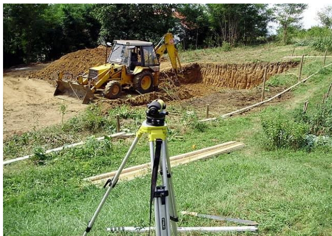
Slika 4.2. Određivanje visinskih razlika uz pomoć nivelira
