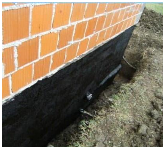
Slika 4.10. Hidroizolacija temelja kuće
