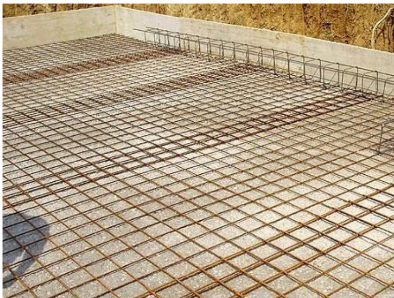
Slika 4.6. Priprema za betoniranje temeljne ploče
