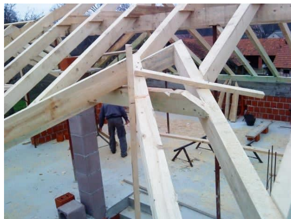
Slika 4.3. Izrada krovne konstrukcije
