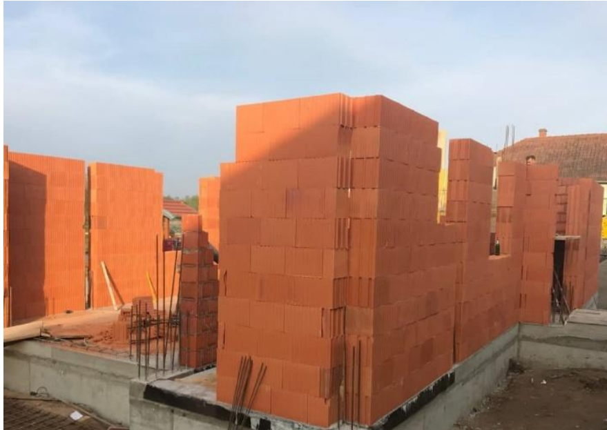
Slika 4.7. Zidanje zidova prizemlja
