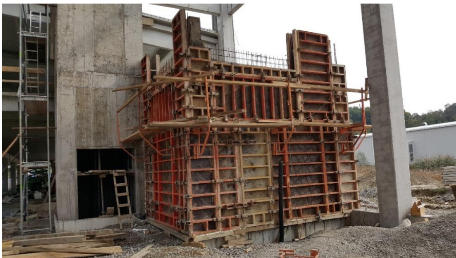
Slika 1.3. Montirana i pripremljena oplata za betoniranje zidova kotlovnica
