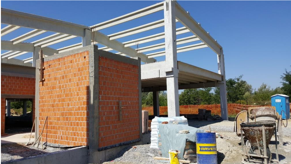
Slika 3.6. Zidanje zidova šupljom blok opekom, na slici vidljivi i horizontalni i vertikalni serklaži
