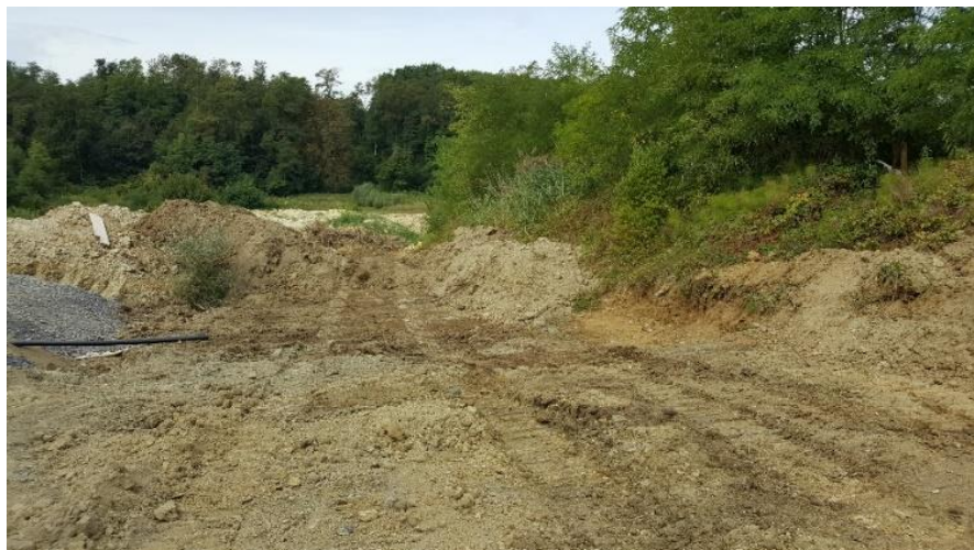
Slika 3.1. Priprema i čišćenje terena za zemljane radove
