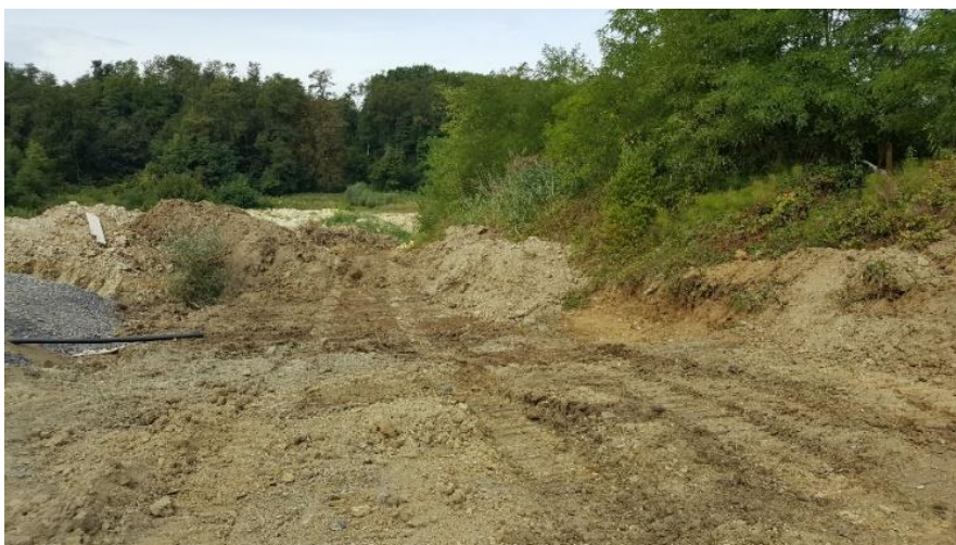
Slika 3.1. Priprema i čišćenje terena za zemljane radove
