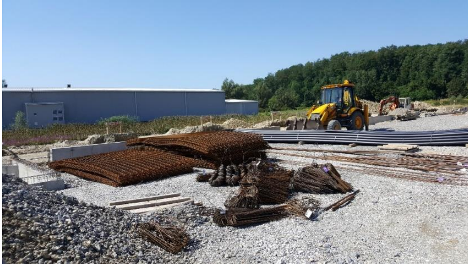
Slika 3.4. Dopremljena armatura iz armiračkog pogona
