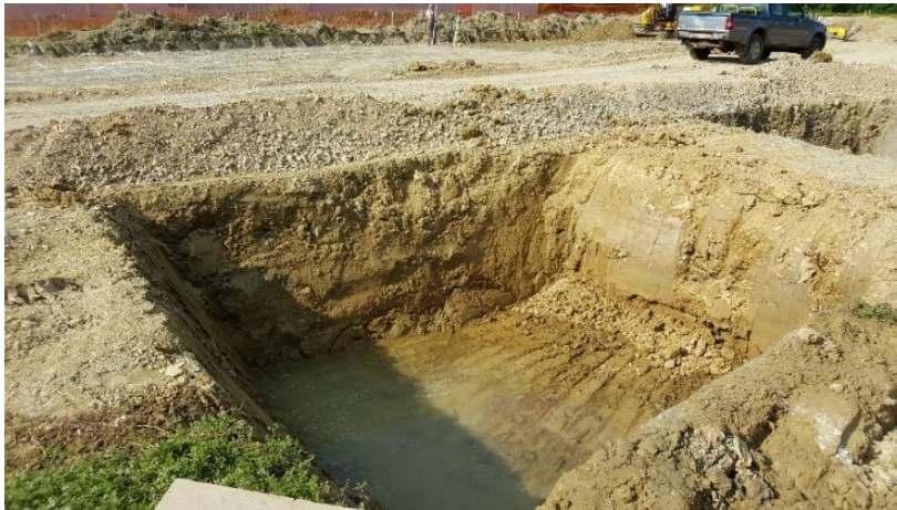
Slika 3.2. Strojni široki iskop temeljnih stopa
