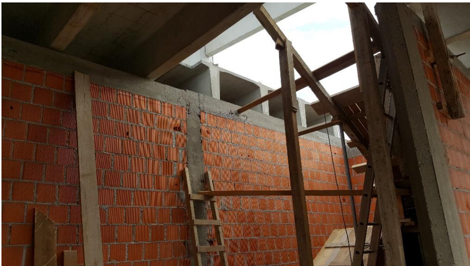
Slika 3.7. Unutarnji pregradni zidovi izvedeni šupljom blok opekom
